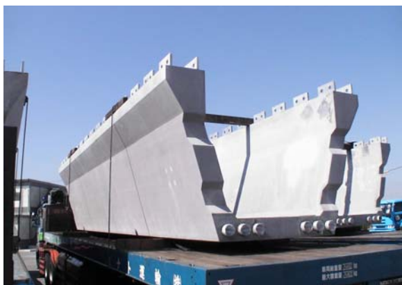
写真－2 鉄筋不使用のプレキャスト桁 Photo 2 Precast girder of GSE Bridge
