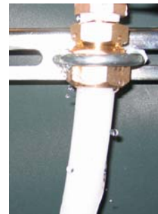
写真-2 袋ナット締込み不足による漏水 Photo.2 Leakage of lack of torque of nut
