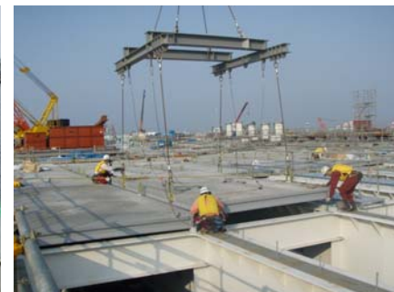
写真-15 架設状況 Photo 15 Erection
