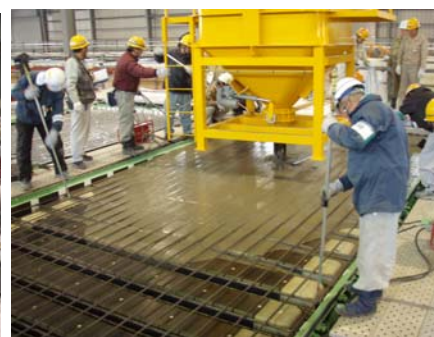
写真-12 打設状況 Photo 12 Pouring UFC to slab
