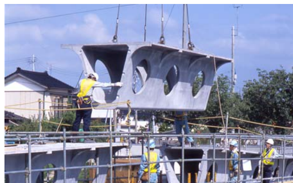
写真-3 酒田みらい橋 架設状況 Photo 3 Erection of Sakata Mirai Bridge
