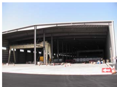
写真-10 UFC床版製作工場 Photo 10 UFC slab factory
