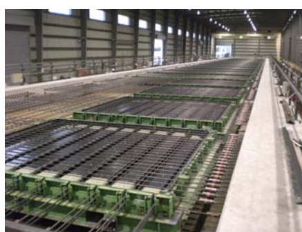
写真-11 UFC床版製作ライン Photo 11 UFC slab production line
