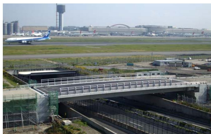
写真-6 東京国際空港(羽田)国際線地区 GSE 橋梁 Photo 6 Tokyo International Airport (Haneda) GSE Bridge
