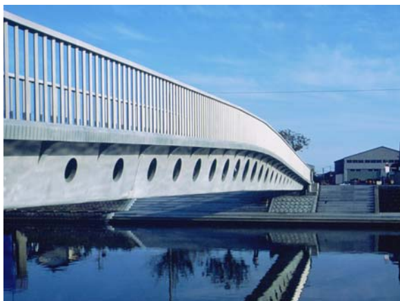
写真-2 酒田みらい橋 Photo 2 Sakata Mirai Bridge
