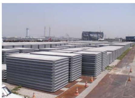
写真-13 UFC床版ストック状況 Photo 13 Stock of UFC slab
