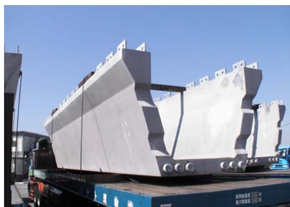
写真-7 鉄筋不使用のプレキャスト桁 Photo 7 Precast girder of GSE Bridge
