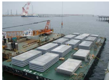
写真-14 運搬状況 Photo 14 Transportation
