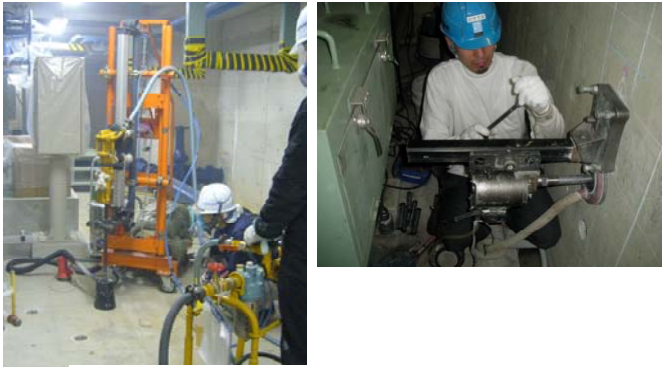
図-11 下向き・狹隘部における施工状況
