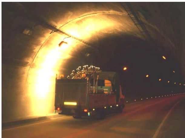
写真－1 現地撮影状況 Photo.1 Crack investigation of tunnel lining
