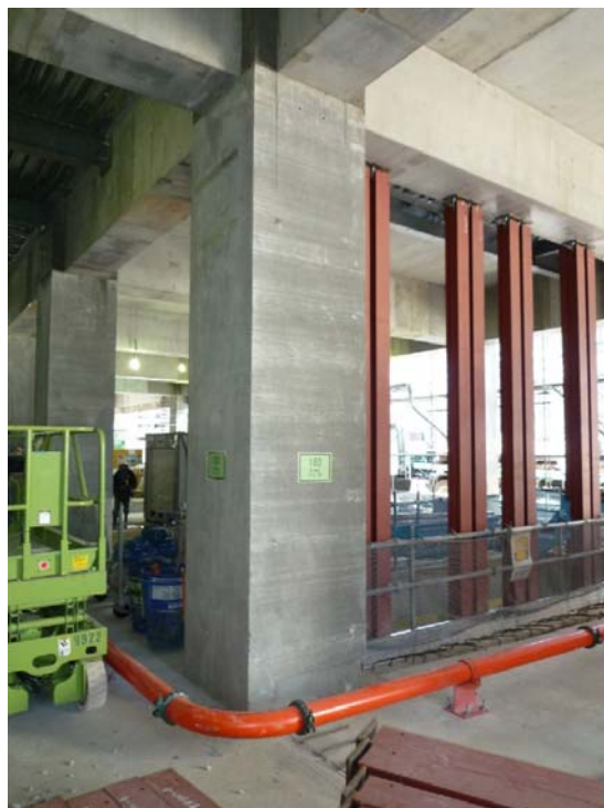
写真-4 設置された Fc160 の PCa 柱 Photo4 160MPa precast concrete column
