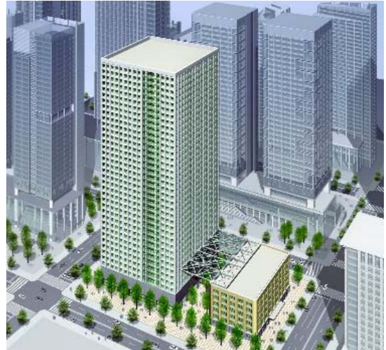
図-9 連結屋根制震システムの試設計(全景) Fig.9 Interaction control system
