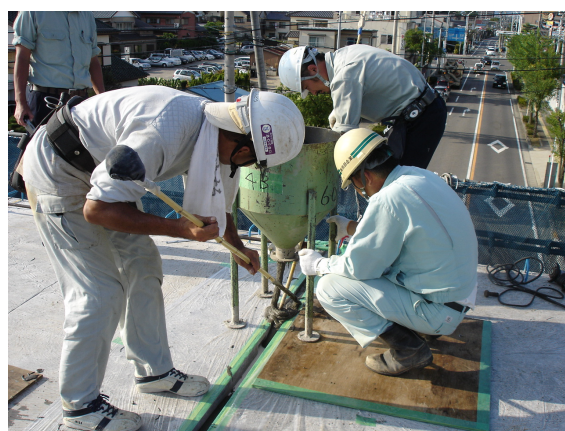
写真-8 ウェットジョイント部の施工
