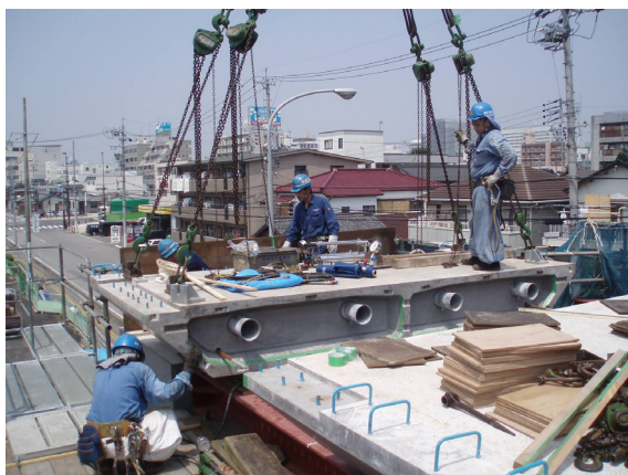
写真-6 柱頭部セグメントの設置
