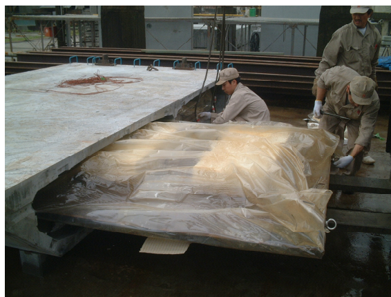
写真－4 内型枠の脱型 Photo.4 Stripping of inner form
