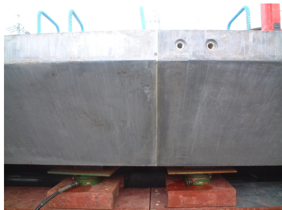
写真-9 ドライジョイント部
