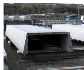
写真-8 脱型後のブロック Photo 8 Girder after removing
