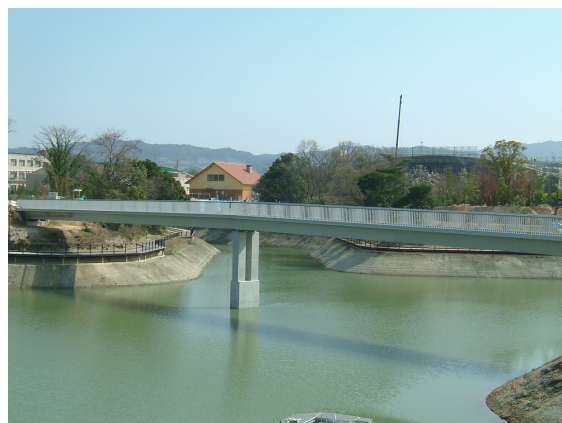
写真-3 橋脚形状（施工中の低水位時） Photo 3 Shape of pier
