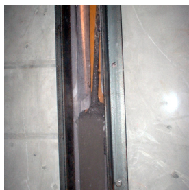
写真-12 充填の確認
