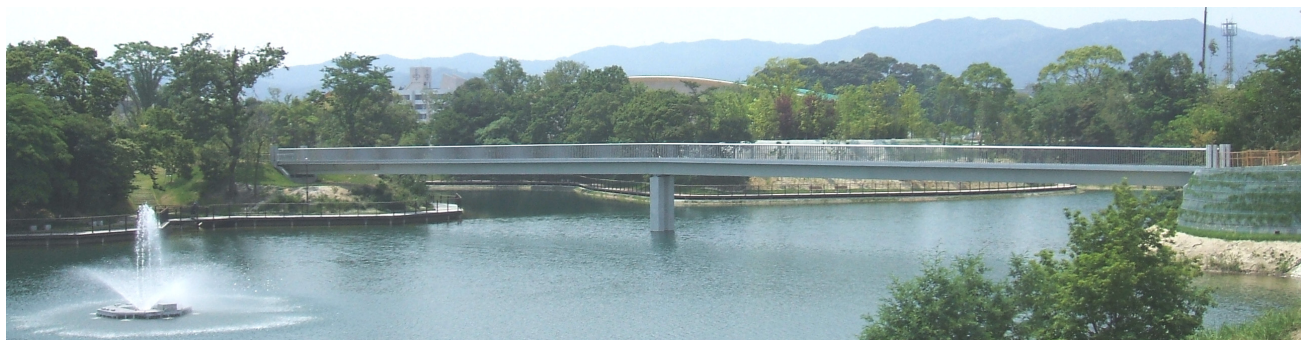
写真-4 完成後の橋梁全景
