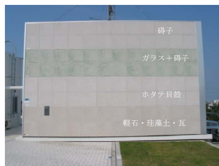
写真-2 クールウォールの設置状況 Photo.2 The setting situation of Cool-Wall
