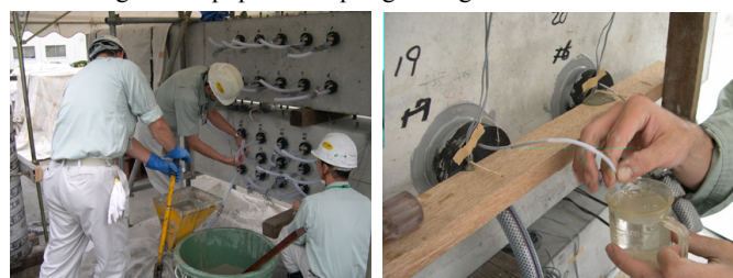
手押しポンプによりグラウトを充てんする
