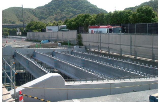
ダクトル桁架設完了写真
