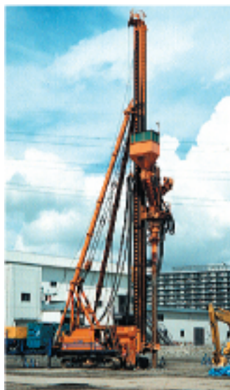
静的締固め工法
