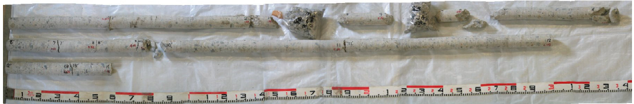
写真-2 コアボーリングによる杭長調査結果 (No. 5杭 杭長=8.09m)
