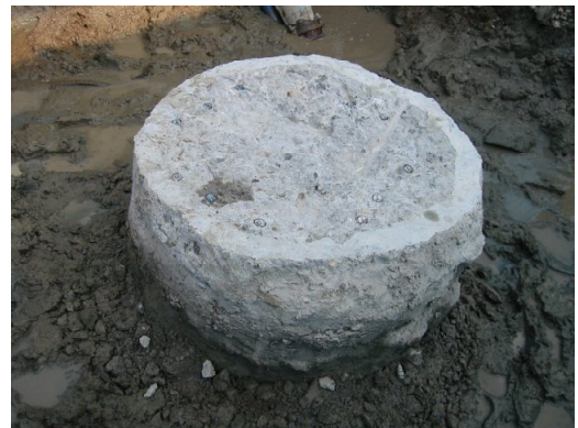
写真-1 既存杭の杭頭部の状況 (No. 5杭, 杭径: 約750mm)
