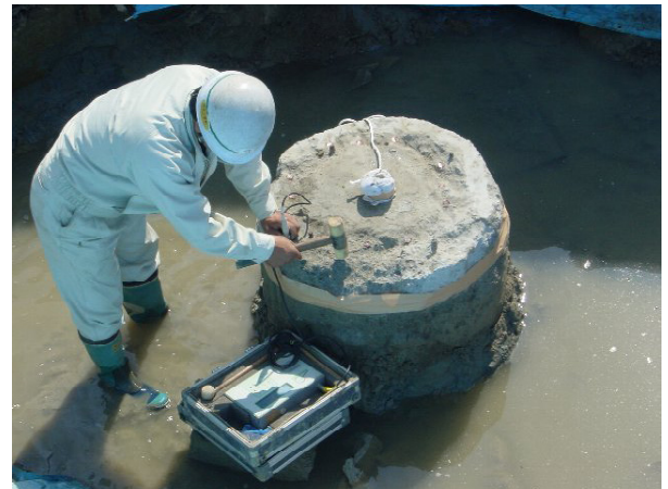
写真-3 IT試験の状況 (No. 5杭)
