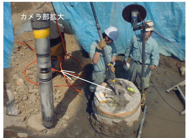
写真-4 ボアホールカメラによる調査
