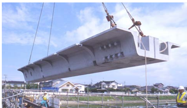
写真-7 酒田みらい橋 端部ブロック写真
