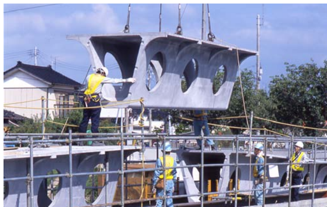
写真-5 酒田みらい橋の架設
