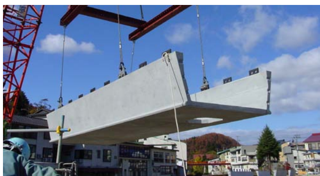
写真-8 赤倉ゆけむり橋 U桁ブロック写真
