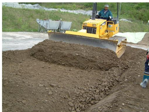
写真-2 打設状況 (ブルドーザによる撒出し)
