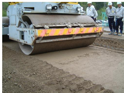
写真-3 締固め状況 (振動ローラによる転圧)
