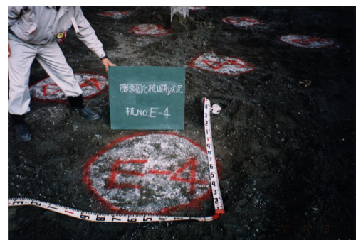
写真-6 「TAFDEX」試掘調査状況 Excavation of 'TAFDEX'
