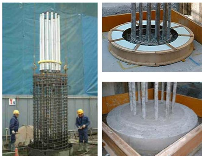
写真-2 施工状況 (場所打ちコンクリート杭)
