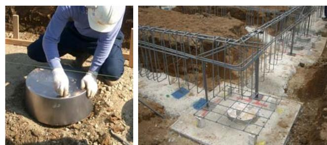
写真-3 施工状況 (既製コンクリート杭)
