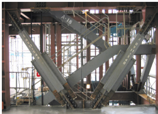
写真-2 設置状況 Installation condition
