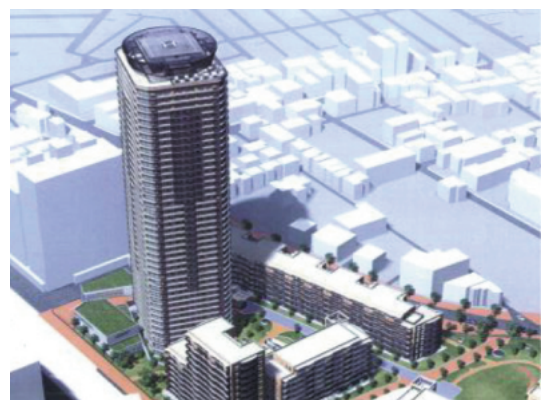
図3 ハイブリッド免震を適用した41階建て地上135m、世界最高の免震建物「サウザンドタワー」、2003年12月竣工。柱には100KN/mm 2 の超高強度コンクリートが用いられている。2004年度建築学会賞（技術）を受賞。
