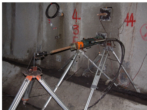
写真-1 引抜き試験状況 Pull-out Test
