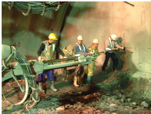
写真-2 ボルト挿入状況 Overview of Bolt Installation
