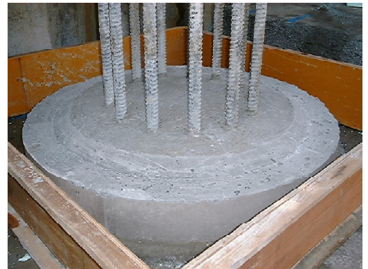
(c) 杭頭部の仕上がり
