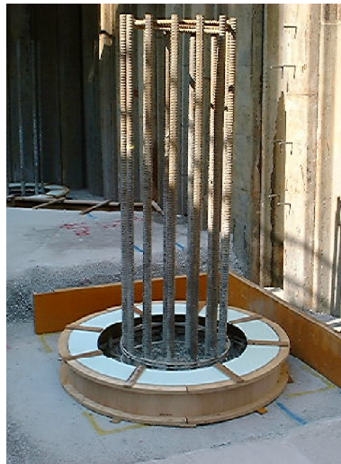
(b) 杭頭型枠設置状況
