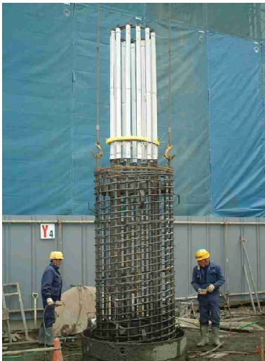
(a) 鉄筋籠の吊り込み
