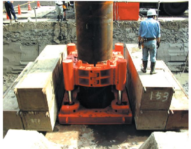
鋼管による既設杭の耐震補強（鋼管圧入状況）
