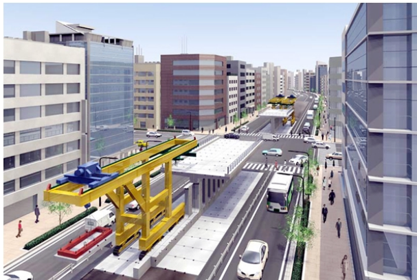
図-9 プレキャストブロック据付状況 (TQB-B工法) Setting of precast concrete blocks on TQB-B construction method
