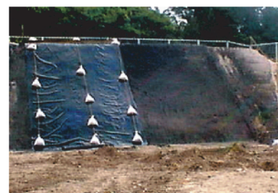
敷設実証実験
