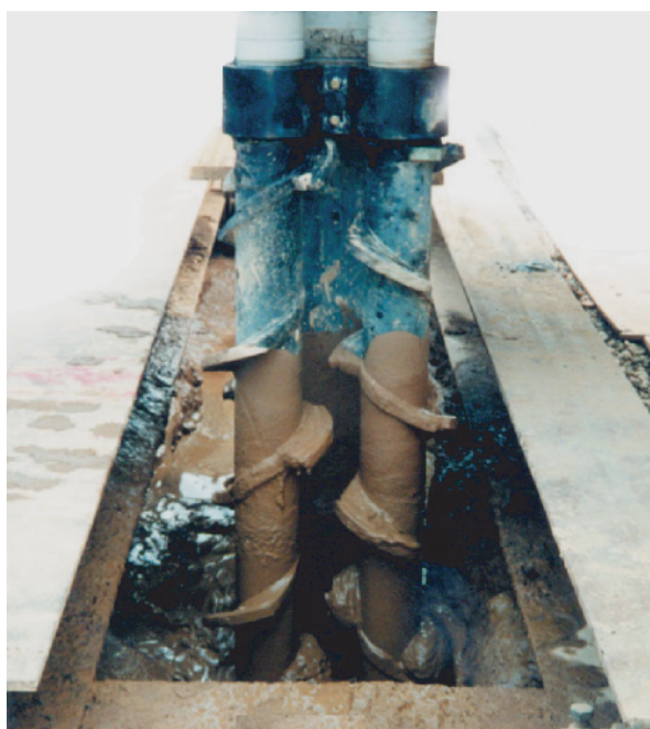
原位置攪拌工法による地中連続壁造成
