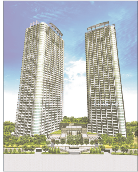
Fc100N/mm 2 の超高強度コンクリートを使用した RC高層マンション（単位水量管理を実施）
