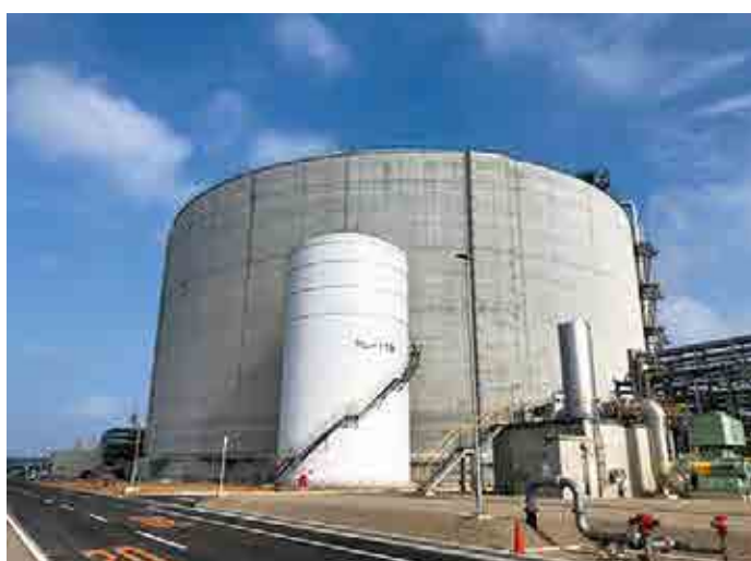
新居浜LNG基地 LNG貯槽(2022、愛媛県)
