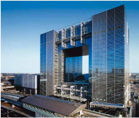
テレコムセンタービル
