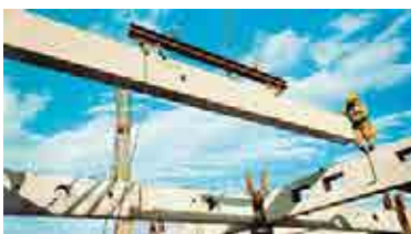
PCa小梁取り付け工事
