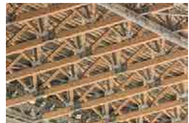
鉄骨と木材のハイブリッド構造
