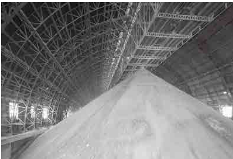
大成トラス実用化第1号となった 東洋高圧砂川工場
