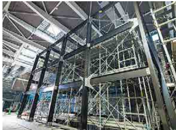
CFRP 部材を用いた防振遮音構造フレーム
