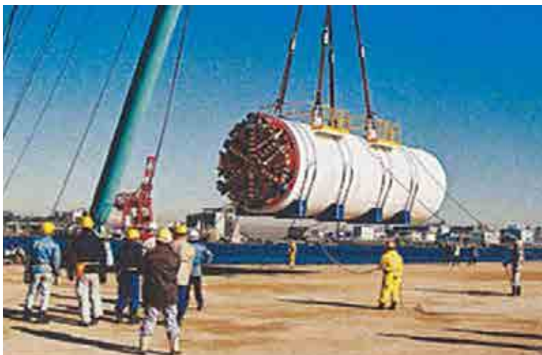
立坑に投入されるシールドマシン
