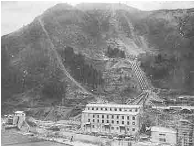
信越電力中津川水力発電所(1923、新潟県)
