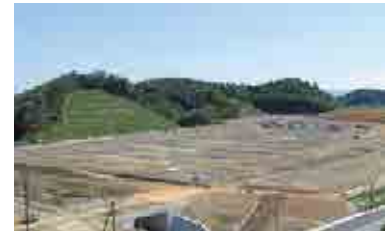
東松島市野蒜北部丘陵地区震災復興事業 中工区宅地
