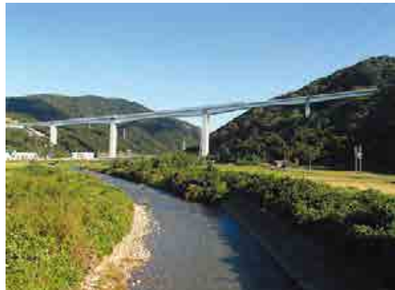
舞鶴若狭自動車道 笹の川橋
