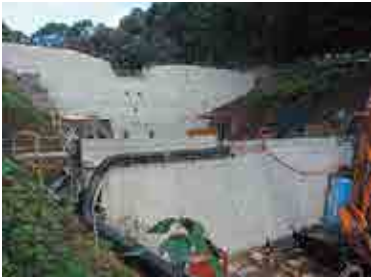
逢初川災害対策事業 新設堰堤施工状況
