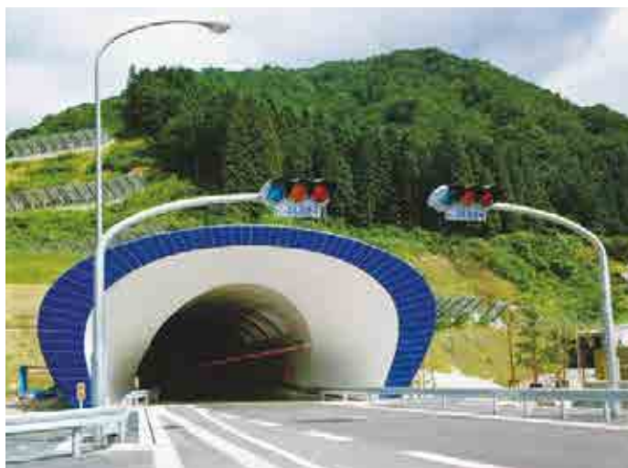
関越自動車道関越トンネル[湯沢側] (1990、新潟県)
