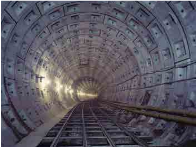
東海道本線有楽町隧道(1972)
