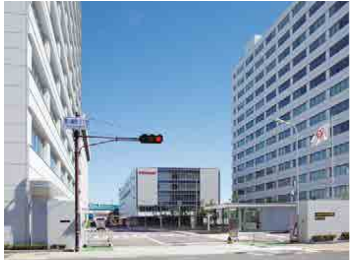
川崎重工神戸工場 新総合事務所(2013)
