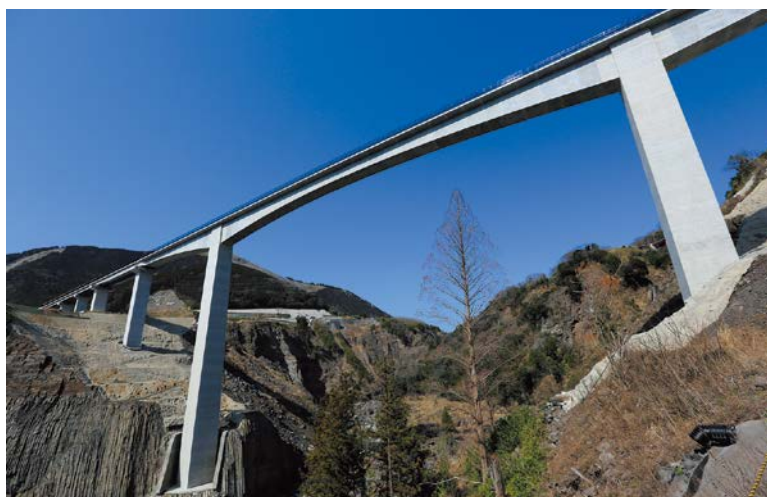
完成した新阿蘇大橋
