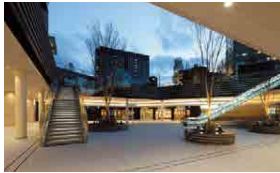
御茶ノ水ソラシティで 1 階の人工地盤を支える地下広場の PCa 柱
