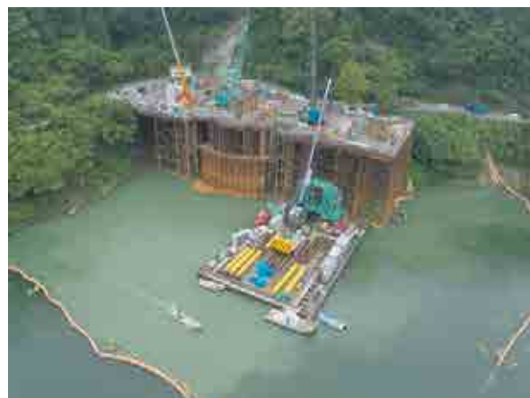
天ヶ瀬ダム再開発トンネル放流設備流入部建設工事に初適用
