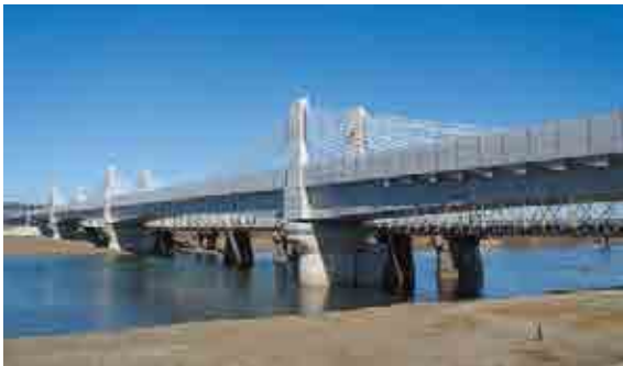
斜張橋に比べ斜材の勾配が緩やかな北陸新幹線神通川橋りょう
