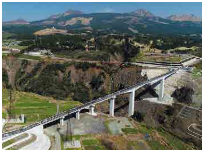
国道325号線 新阿蘇大橋(2021、熊本県)
