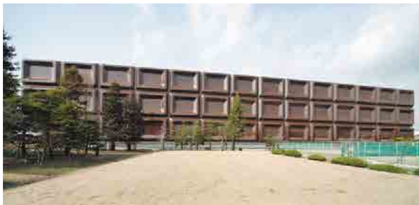
明治大阪工場 新1号館(2011)
