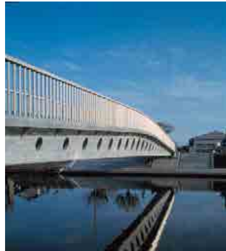
ダクトルを用いた歩道橋・酒田みらい橋
