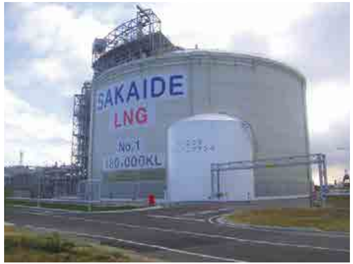
坂出LNG基地(2010、香川県)
