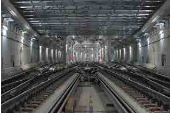
(13号相直) 渋谷駅建設二期工事 [土木工事]
