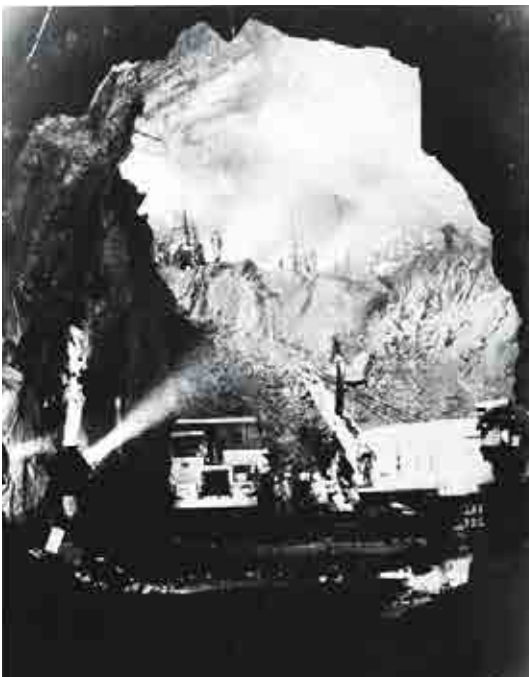
関西電力黒部川第4発電所[第5工区](1961、富山県)
