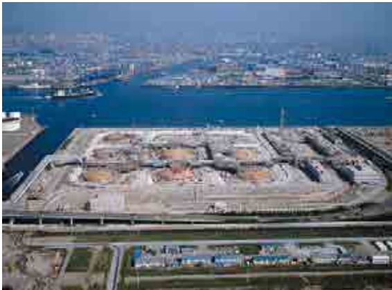
東京電力東扇島地下タンク
