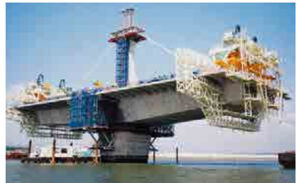
揖斐川橋の西側の上部工事
