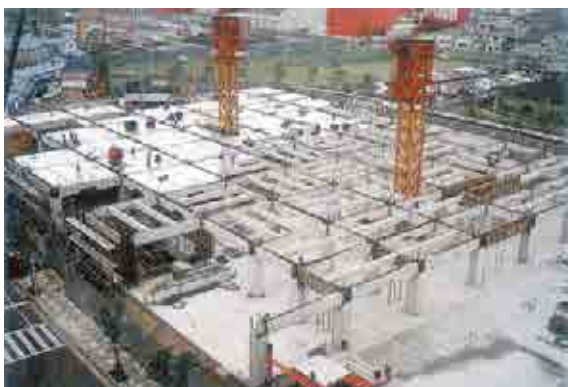
③ 柱・梁・床建方
