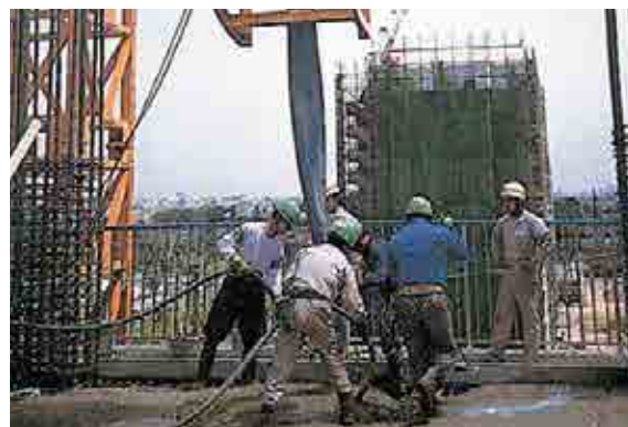
④ コンクリート打設
