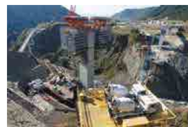
新阿蘇大橋施工状況
