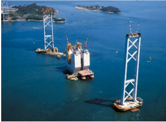
巨大な4A橋台(中央)と3基の橋脚
