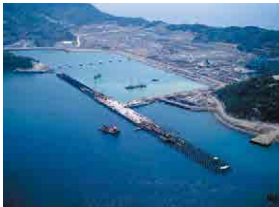
松島火力発電所。右手前に延びるのが新棧橋
