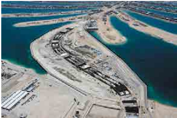
パームジュメイラ道路海底トンネル工事
