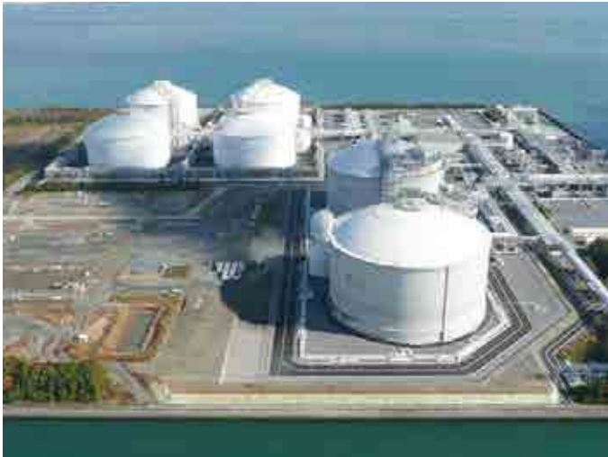
中部電力川越火力発電所LNG設備(2013、三重県)
