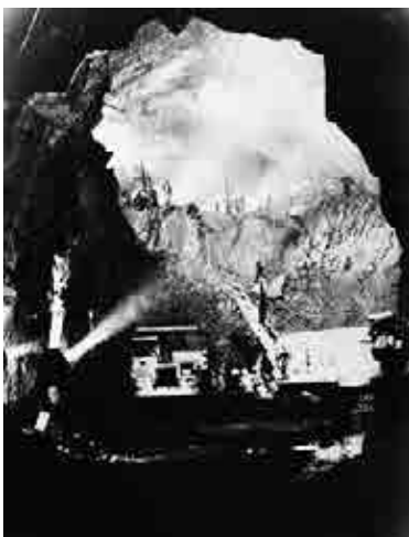
関西電力黒部川第4発電所 地下発電所本体掘削
