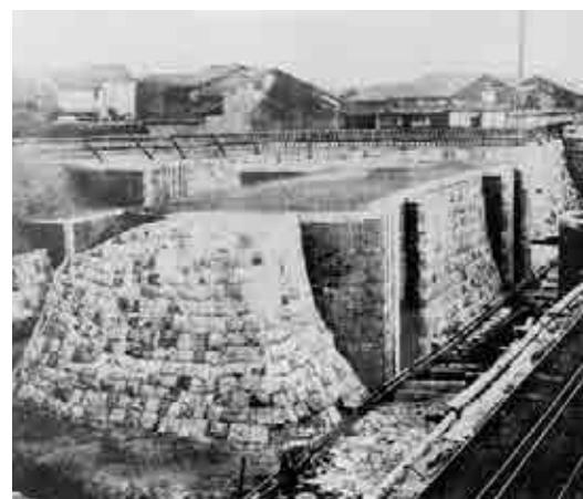
琵琶湖疏水水閘門
