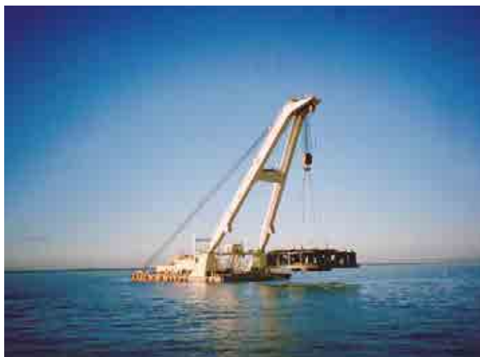
北海道電力苫東厚真発電所復水器冷却用水施設(1980)
