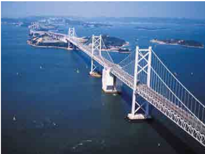
南北備讃瀬戸大橋[下部工、北工区](1985、香川県)
