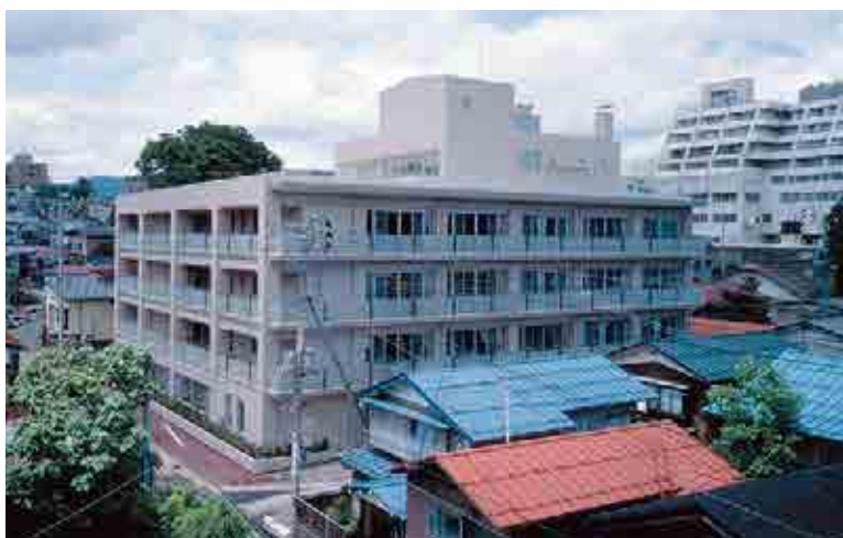
小千谷総合病院老人保健施設「水仙の家」
