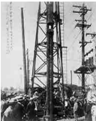
わが国地下鉄工事の口火を切った 第1号杭打ち
