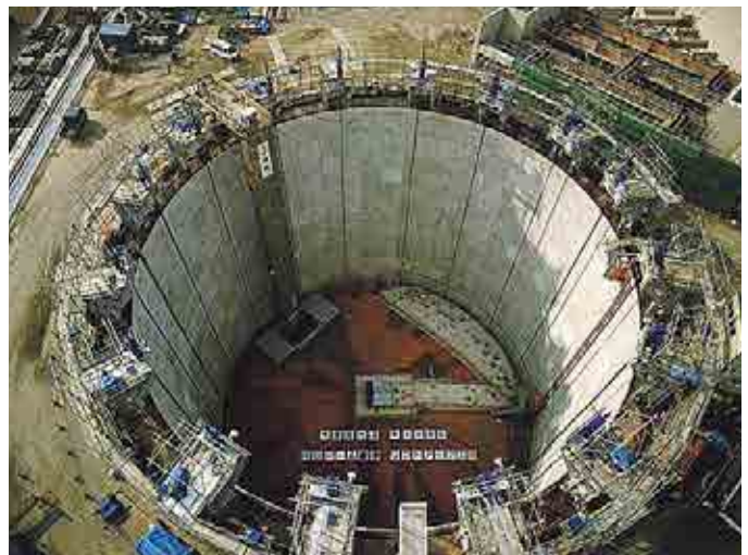
東京ガス扇島工場TP 1LPG地下式貯槽[土木](1998、神奈川県)
