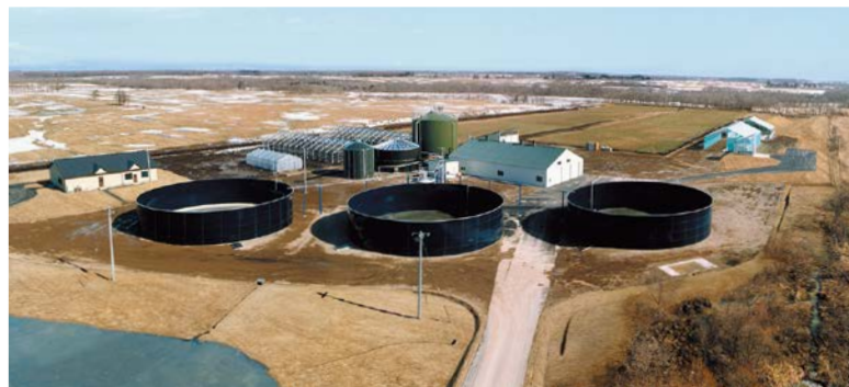
別海地域資源循環プロジェクト・ 家畜糞尿処理施設
