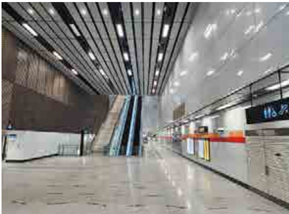
シンガポール・トムソン東海岸線建設工事 T226工区 既設2営業線(南北線・環状線)に繋がる連絡通路階
