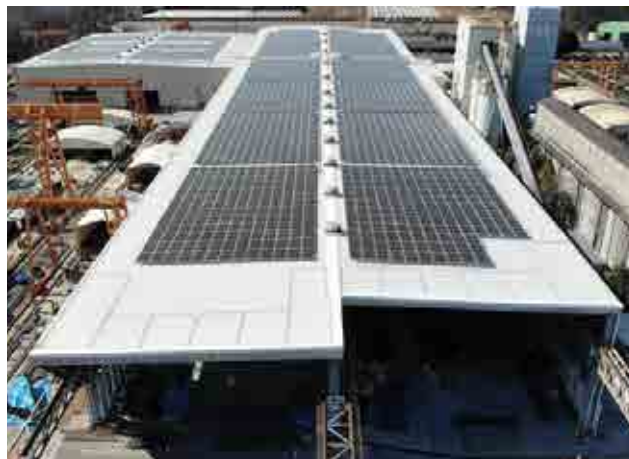
ZEB 化リニューアルした川越工場
