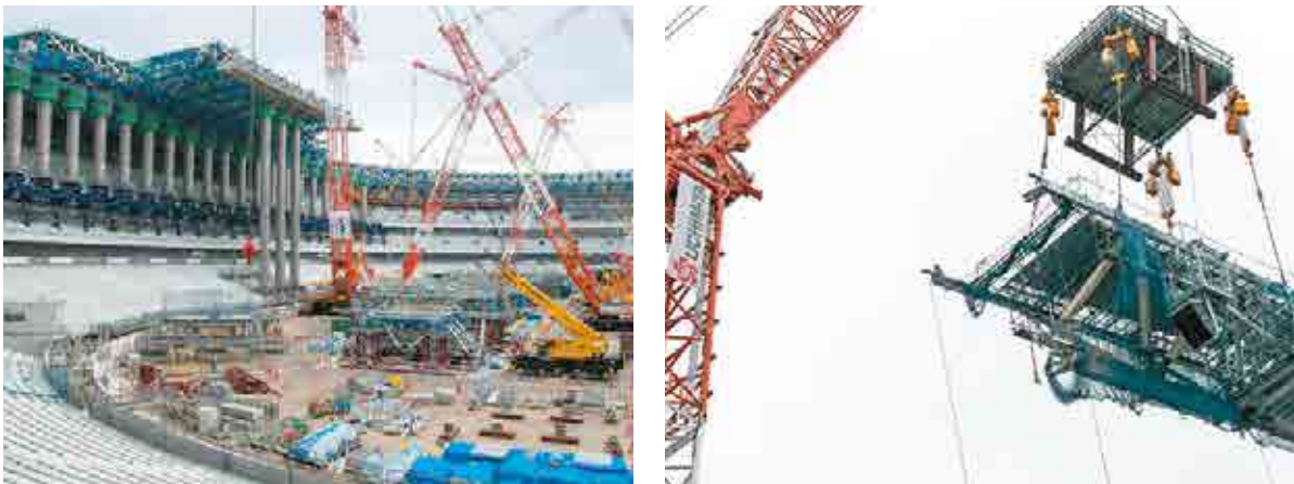
屋根工事(クローラクレーンで吊り上げ)
