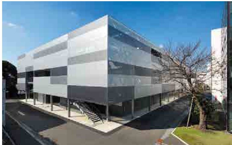
次世代研究開発棟 (材料と環境のラボ)
