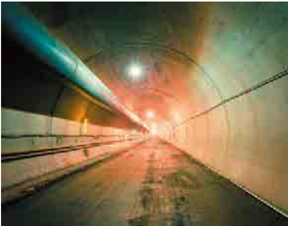
水環境保全に特に留意した八王子城跡トンネル
