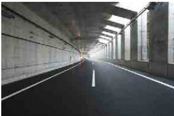
東京外かく環状道路 田尻工事 本線 (写真提供：NEXCO 東日本)
