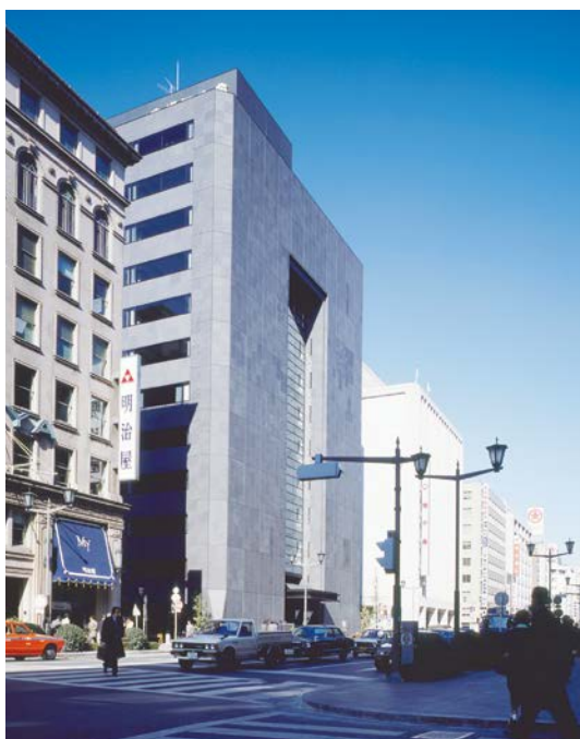
京橋千代田ビル(1981)
