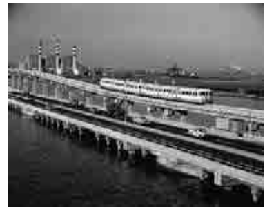
日本高架モノレール羽田線 [第1・第3工区]
