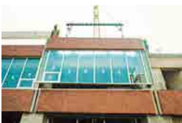
外壁取り付け工事
