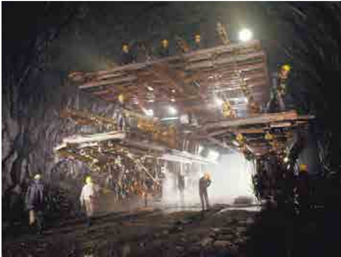
上越新幹線大清水トンネル(1978、新潟県)
