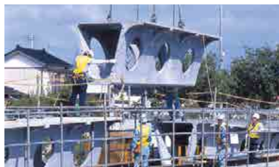
国内初のダクトアルを使用した酒田みらい橋
