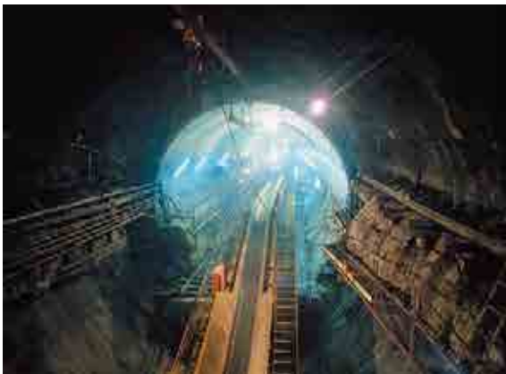
掘削中の青函トンネル
