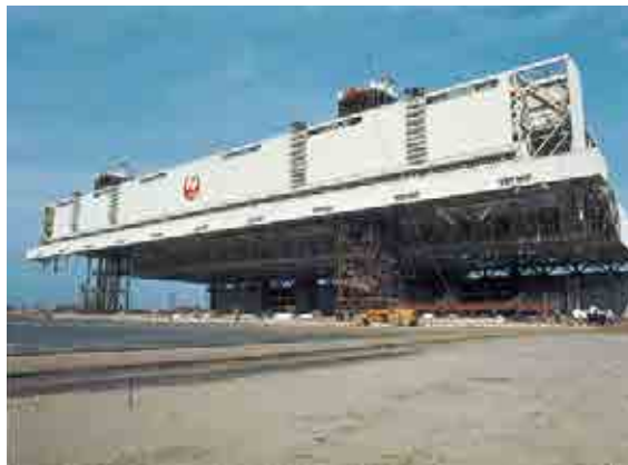
中間支柱のない巨大な日本航空成田第1ハンガー
