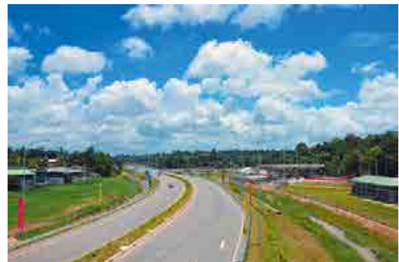
スリランカ・コロンボ外郭環状道路 北工区-1(OCH)
