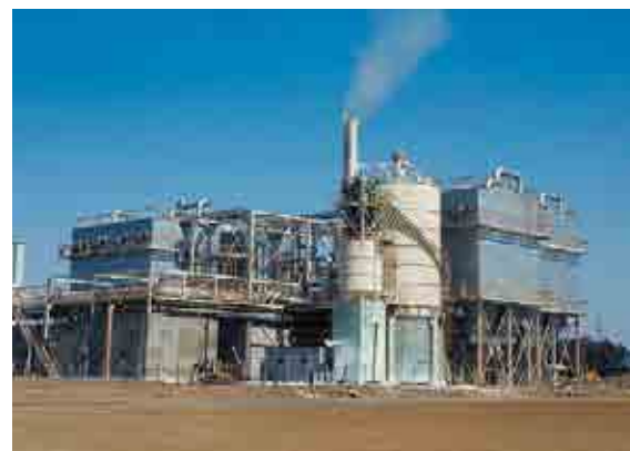
乾式フッ素ガス除去システムを採用した 当時の旭ファイバーグラス茨城工場
