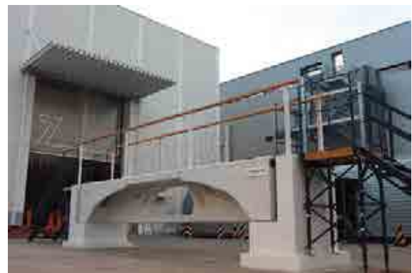
T-3DP で製作した PC デモ歩道橋
