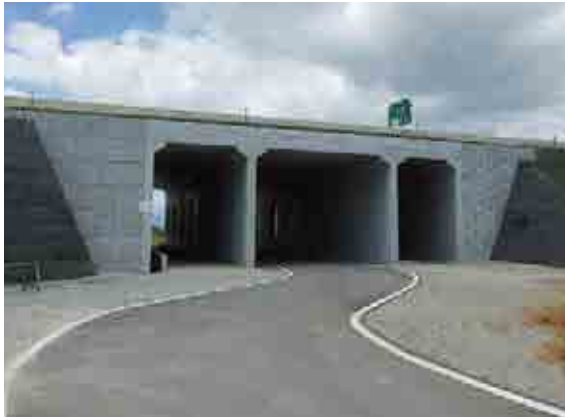
常磐自動車道 岩沼工事 プレキャスト函渠工
