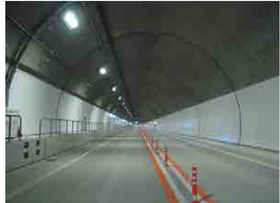
高い土圧や高圧多量の湧水を克服して完成した飛驒トンネル
