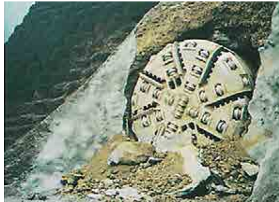
清水第三トンネルを見事に貫通したTBM
