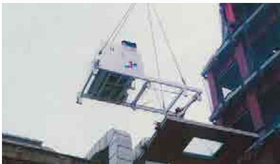
外壁パネルを水平にして運び上げる揚重クレーン
