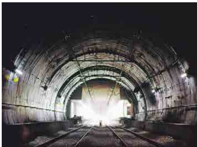
近鉄難波シールド[上本町駅～難波駅] (1970、大阪府)
