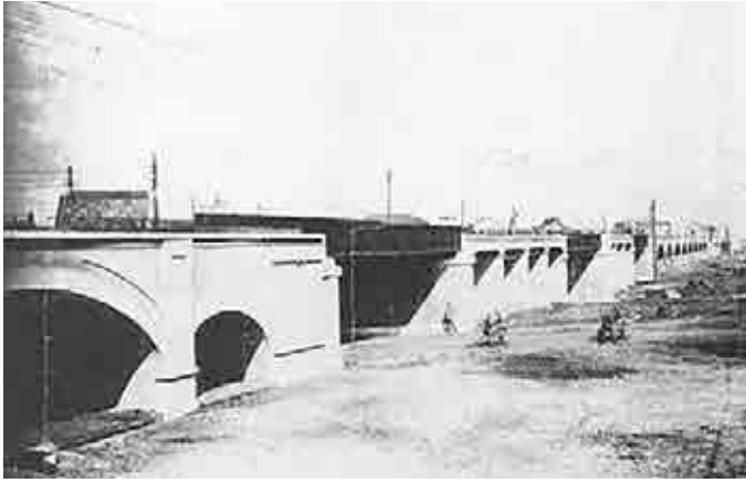
東京市街高架線[東京駅～万世橋～新常盤橋間] (1917)
