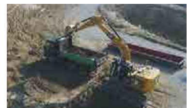
T-iROBO Excavator の施工状況
