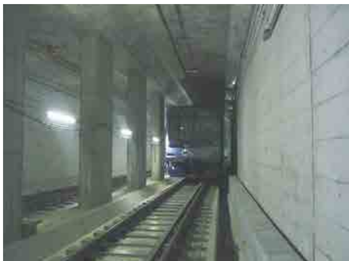
東急東横線 東白楽～横浜駅間地下化[第2工区](2006)
