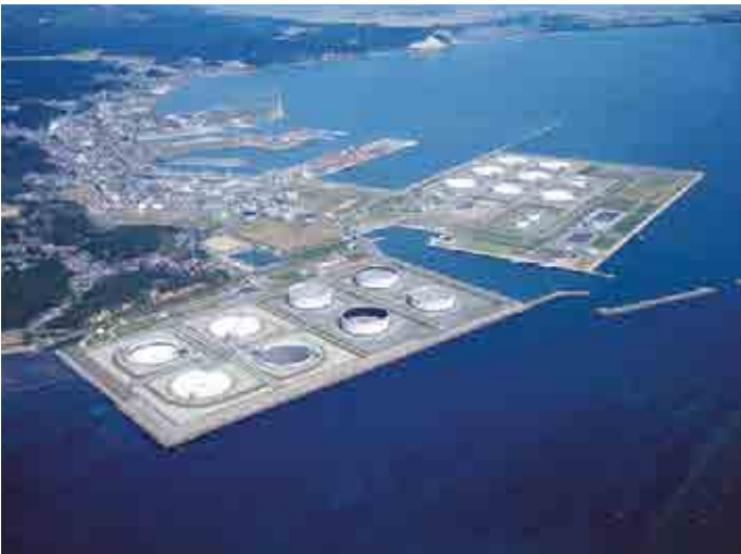
秋田石油備蓄東基地(1992)
