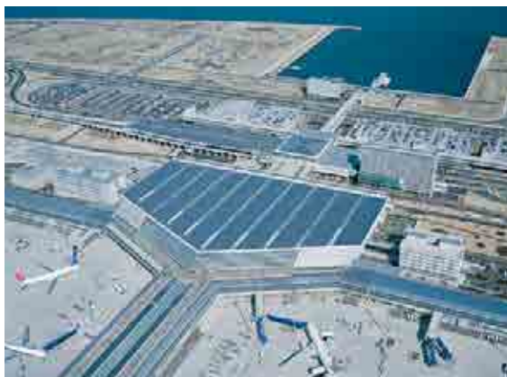
中部国際空港ターミナルビル
