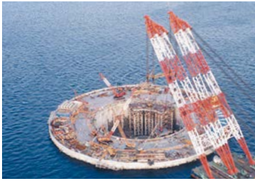
東京湾横断道路川崎人工島の換気塔工事
