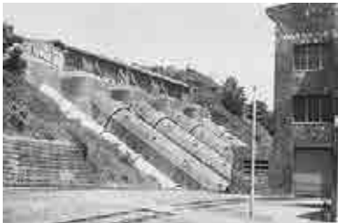
信濃川発電所 (千手発電所)
