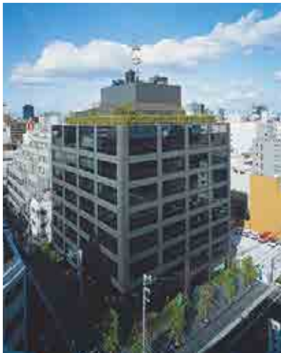
建設当初の大阪支店
