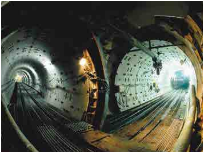
観音川雨水滞水池導水渠(1994、神奈川県)
