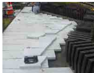
舗装ブロック施工状況
