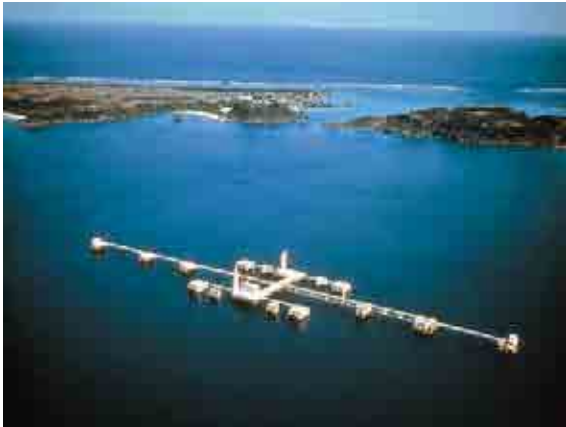
50万t級タンカーが接岸可能な沖縄石油 CTS シーバース
