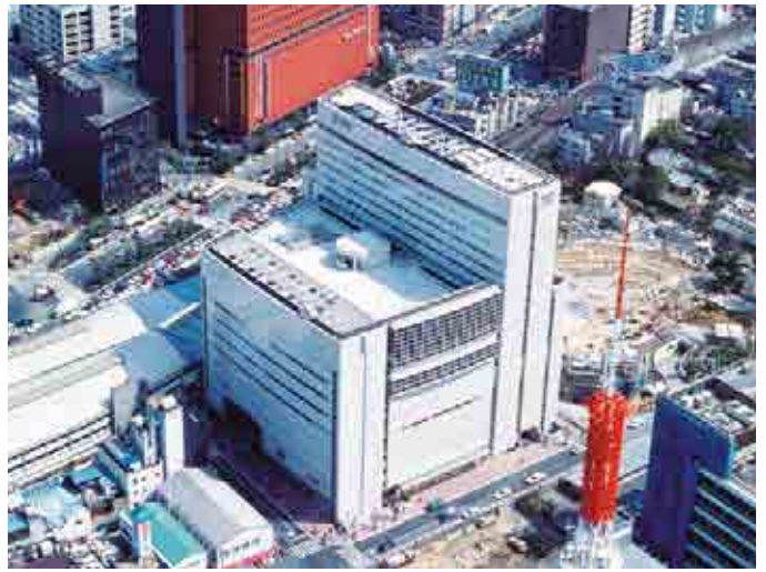
西鉄ソラリアプラザビル(1989、福岡県)
