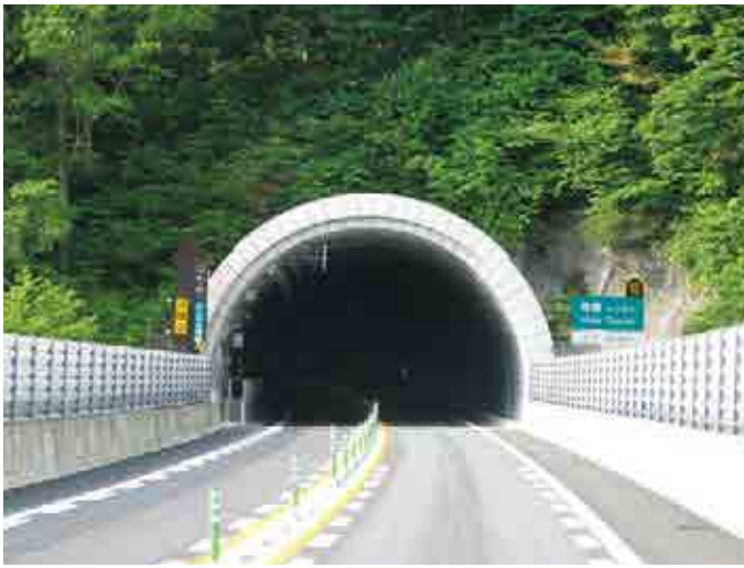
東海北陸自動車道 飛驒トンネル(2008、岐阜県)
