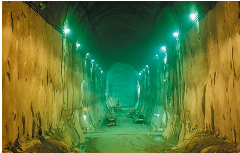
花崗岩をくり抜いた 菊間国家石油備蓄基地のトンネル
