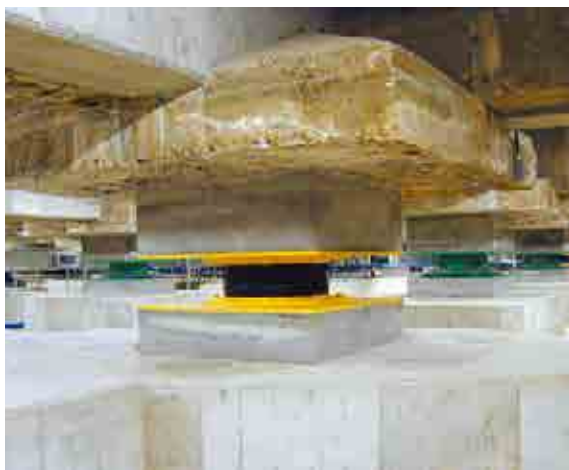
従来の基礎下に造られた免震ピット(豊島区役所)
