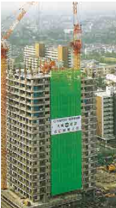
工事中のGH光が丘B-18号棟
