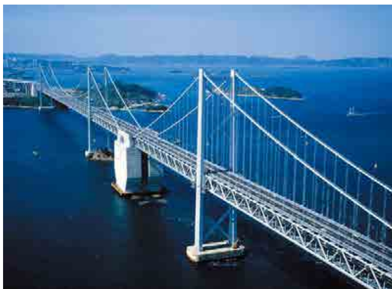
南北備讃瀬戸大橋
