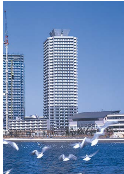
日本で初めて超高強度コンクリートを本格的に採用したトミンタワー台場一番街
