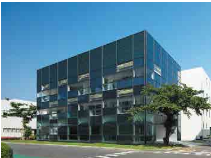
大成建設技術センター ZEB実証棟(2014、神奈川県)
