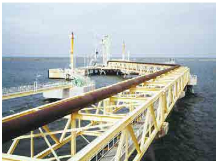
新潟東港第3号栈橋(1976)
