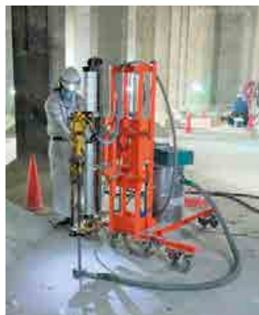
地下配水池への適用状況
