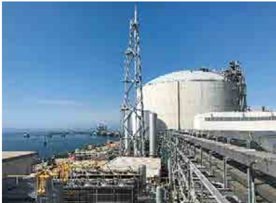
新居浜 LNG 基地 LNG 貯槽
