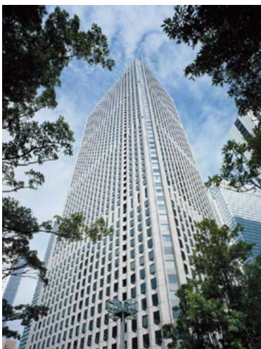
完成した新宿センタービル
