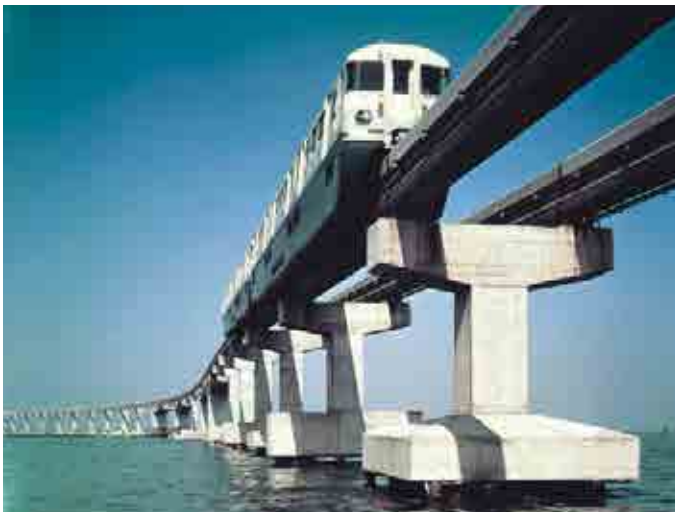
日本高架モノレール羽田線[第1・第3工区] (1964)
