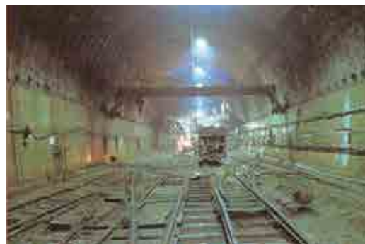
青函トンネル建設現場
