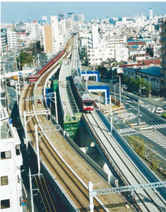
京急新馬場駅—大森海岸駅間高架[第5工区](1995)
