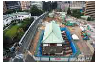
大倉集古館 曳家工事
