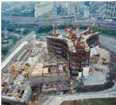
タワー低層部の工事
