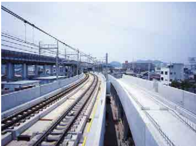
JR西日本姫路駅高架(2009、兵庫県)
