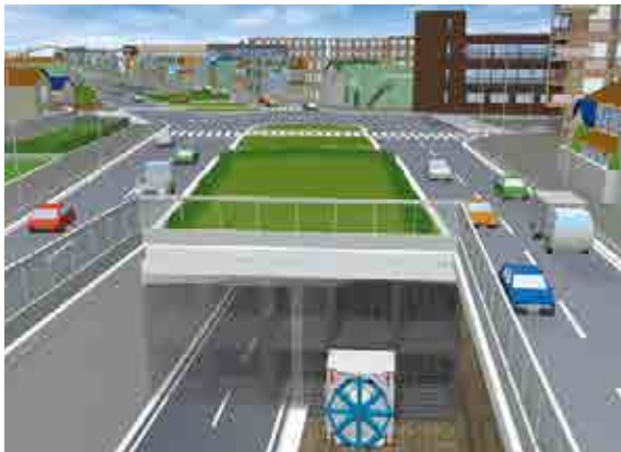
ハーモニカ工法による国道1号線原宿交差点の立体交差 (施工イメージ)
