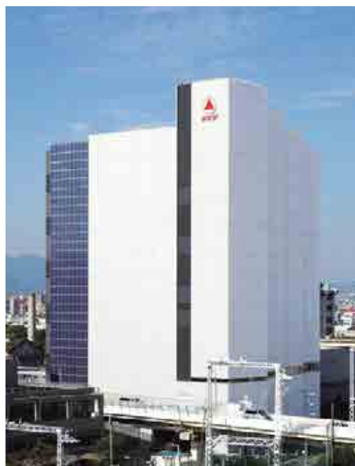
武田薬品工業 治験薬製造施設(2012、大阪府)
