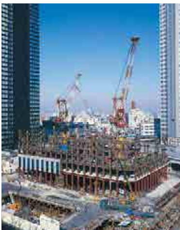
工事初期の新宿センタービル
