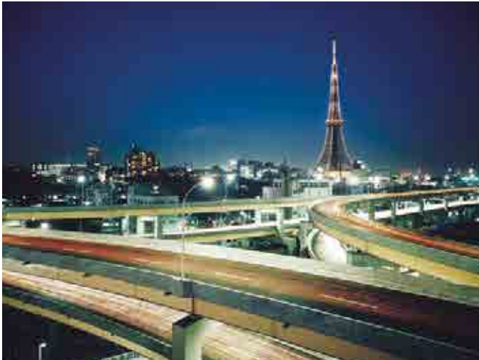
首都高速道路高速都心環状線一ノ橋JCT(1967)
