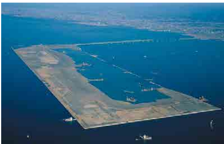
埋立中の関西国際空港
