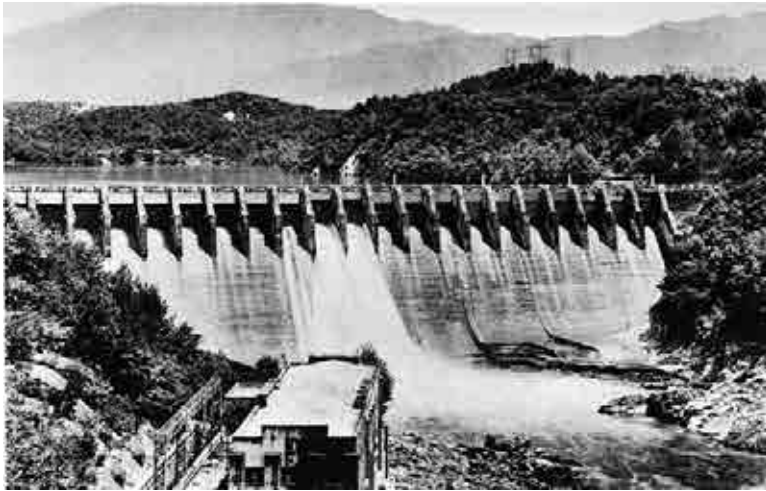
木曾川の大井発電所
