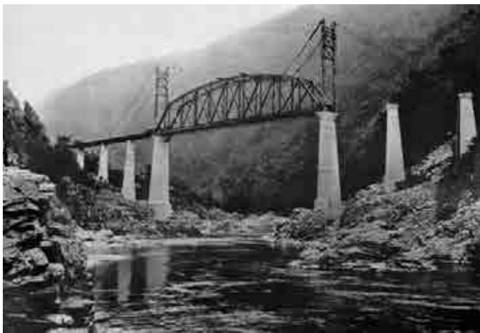
土讃北線第二吉野川橋梁(1935、徳島県)
