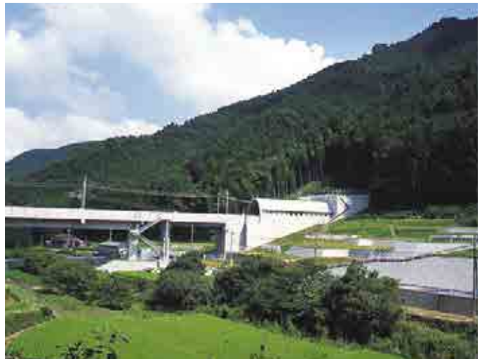
九州新幹線 田上トンネル(2004、熊本県)
