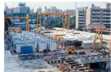
工事敷地内に設けられた製造工場
