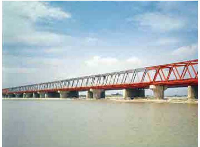
東海道新幹線木曾川橋[下部工](1963、愛知県・岐阜県)
