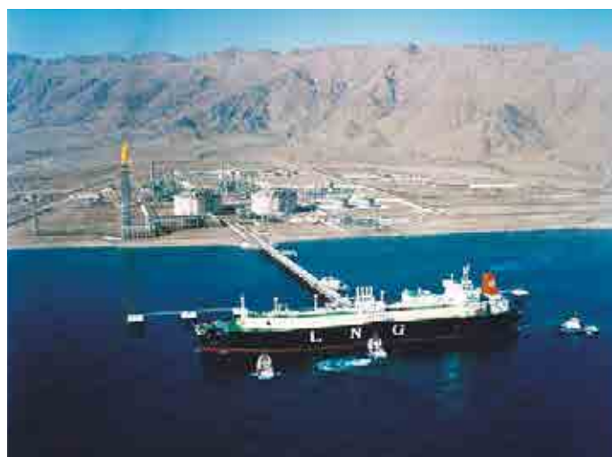
LNGプラント 棧橋及びび取・放水施設(1999、オマーン)
