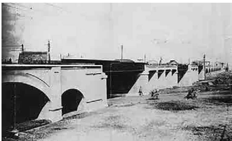
神田駅付近での東京市街高架線
