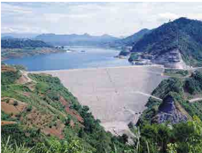
チラタ水力発電所(1988、インドネシア)
