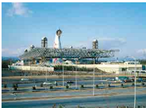
VSL 工法により撤去される大阪万博のお祭り広場大屋根
