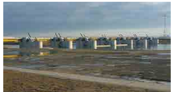
大河津可動堰改築本体Ⅱ期工事
