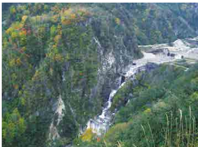
白岩砂防堰堤右岸部岩盤[補強](2002、富山県)
