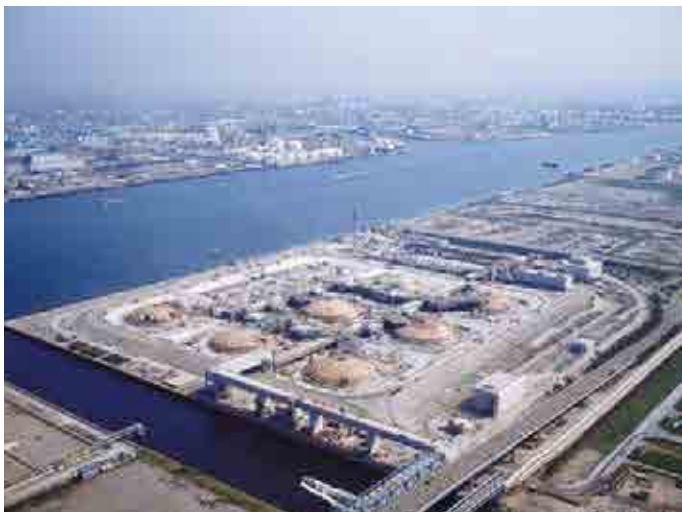
東京電力 東扇島地下タンク2号・5号・7号・8号(1984、神奈川県)
