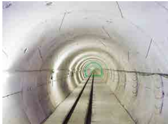
東西関係ガス導管内部
