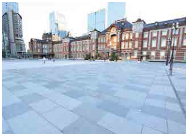
東京駅丸の内駅前広場（インジェクト工法を採用）
