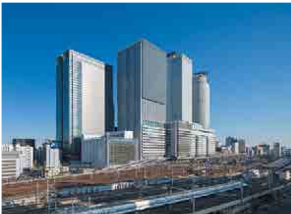
JRゲートタワー（右から3棟目、右の2棟は当社施工のJRセントラルタワーズ）
