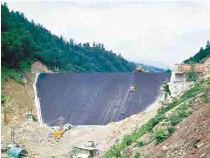
電源開発 大津岐ダム(1969、福島県)
