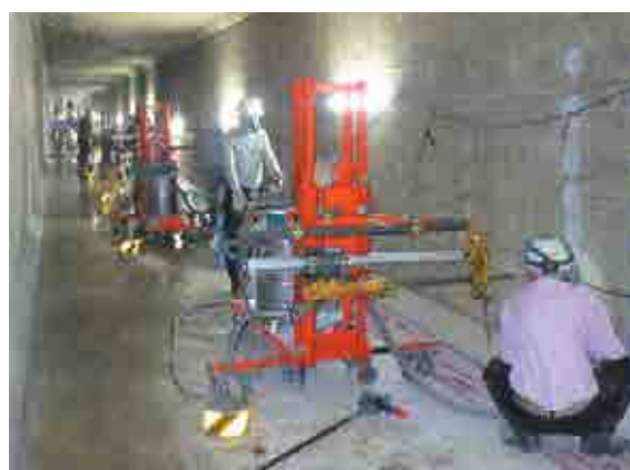
水路カルバートへの適用状況
