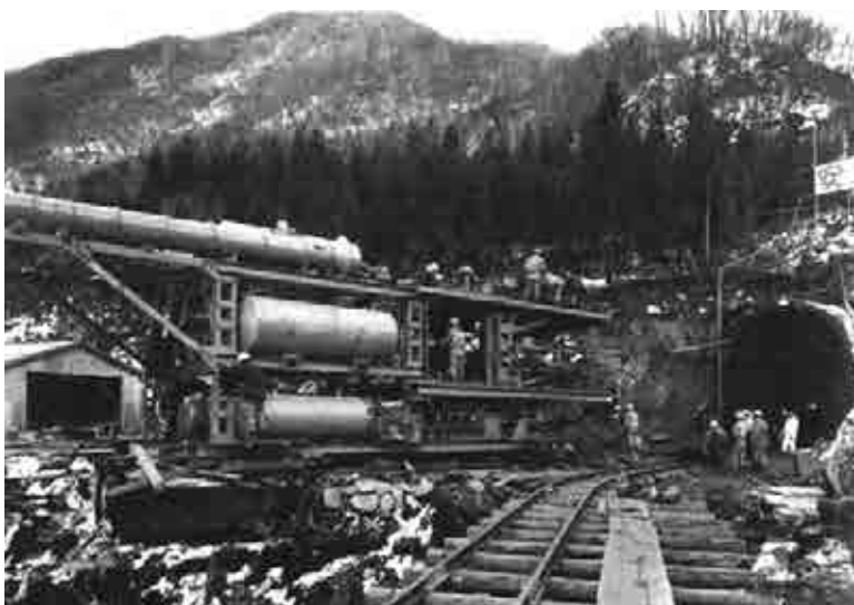
新清水トンネルで使用された 3デッキ13ブームのドリルジャンボ
