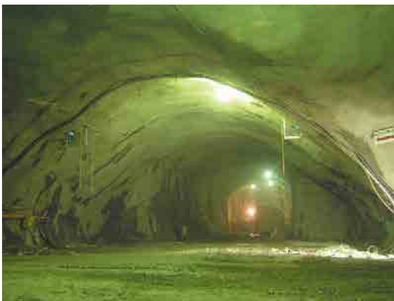
LPG 地下備蓄基地の 水封式地下岩盤貯蔵掘削作業
