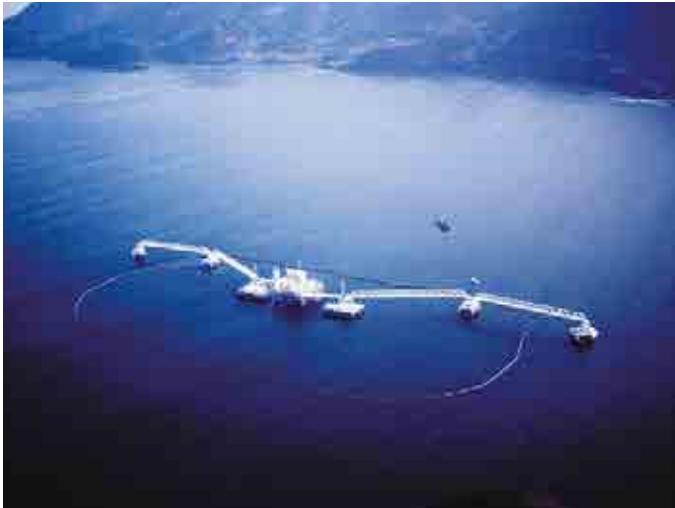
志布志国家石油備蓄基地 シーバース(1991、鹿児島県)
