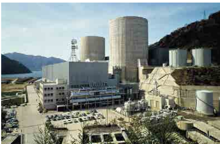
当社初の本格的商用原子炉工事となった 関西電力高浜発電所 1・2号機
