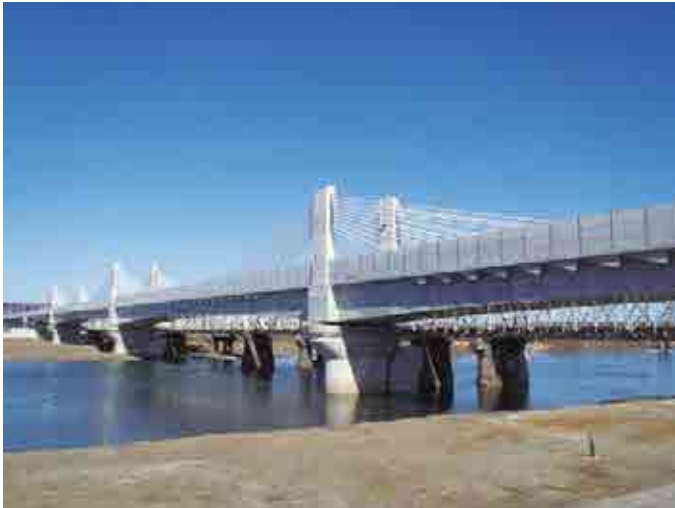
北陸新幹線 神通川橋りょう(2012、富山県)
