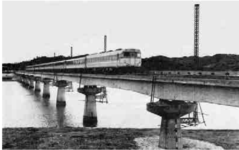
レオンハルト工法を導入した 赤穂線吉井川橋梁
