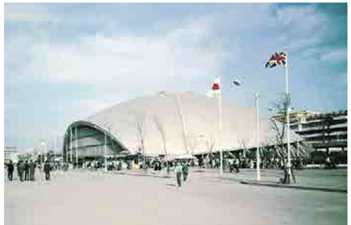
東京国際貿易センター2号館(1959)
