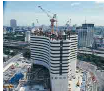
タワー高層部の工事
