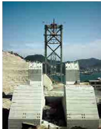
関門高速道路関門橋下関側の橋台
