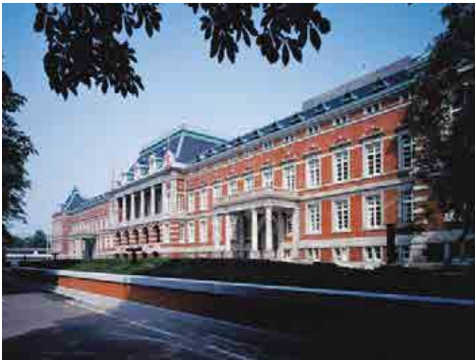
中央合同庁舎第6号館赤れんが棟[保存改修](1995)
