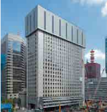
テコレップシステムによる 大手町フィナンシャルセンター解体
