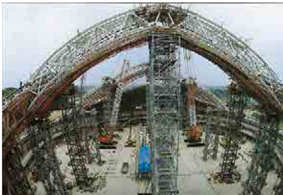
建設中のこまつドーム
