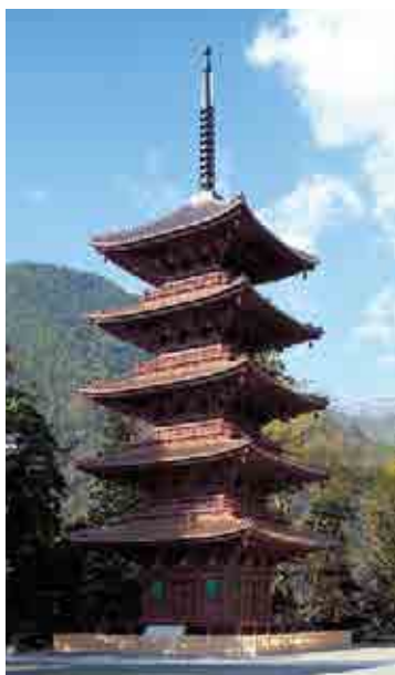
伝統的な建築技法にのって つくられた身延山久遠寺五重塔
