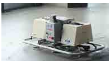
T-iROBO Slab Finisher による床仕上げ施工状況
