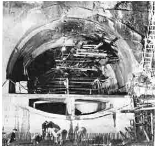
関門国道トンネル[門司側掘削覆土] (1955、山口県・福岡県)
