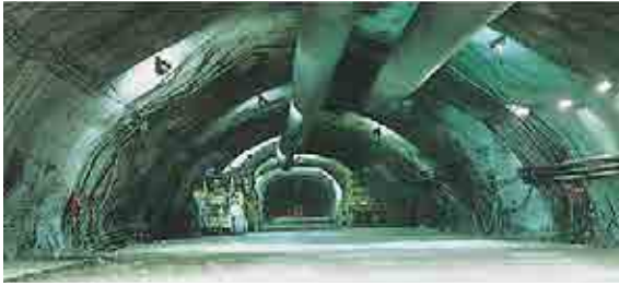
菊間国家石油備蓄基地の岩盤タンク頂設導坑
