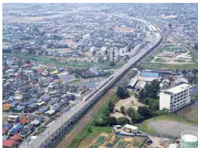
東武日光線 栃木駅付近高架化(2001)
