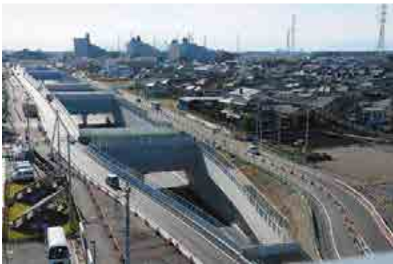
圏央道 桶川北本地区函渠その1
