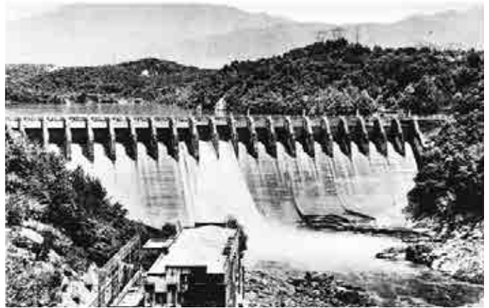
関西電力大井発電所(1924、岐阜県)
