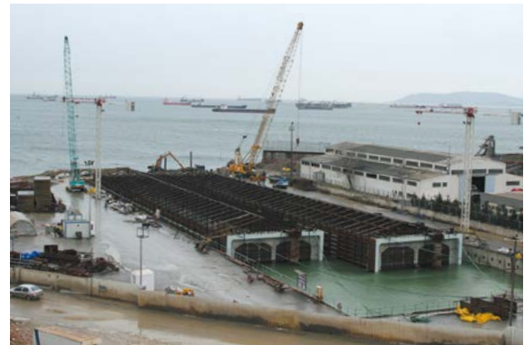
ボスポラス海峡横断鉄道トンネルで製作中の沈埋函
