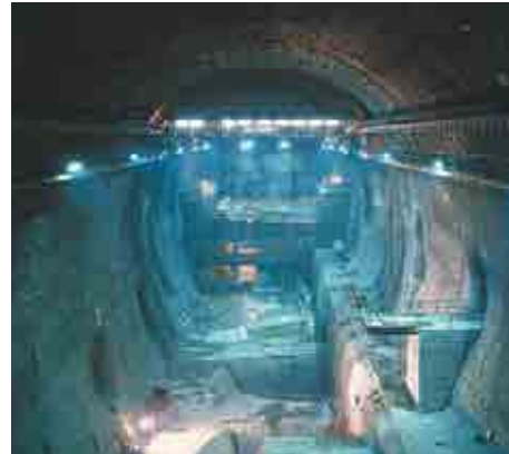
チラタ水力発電所の地下発電所工事
