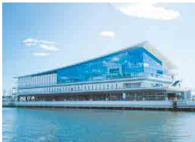
東京国際クルーズターミナル（空調設備施工）
