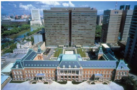
改修を終えた中央合同庁舎第 6 号館赤れんが棟
