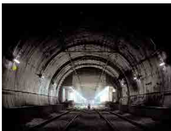
完成間近の近鉄難波シールド
