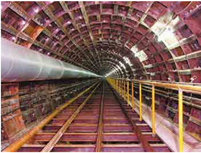
万代～阪南幹線下水管渠(2001、大阪府)
