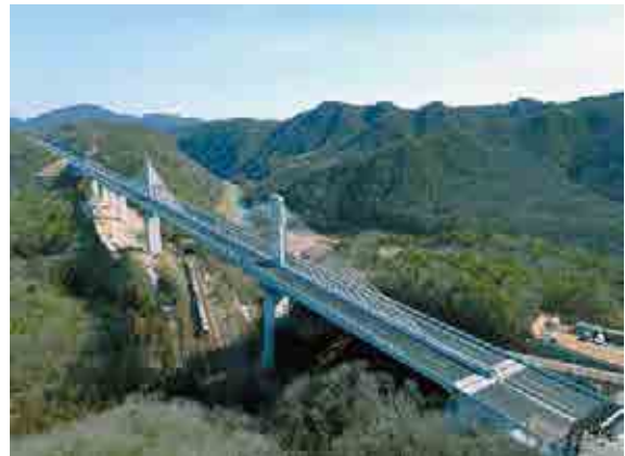
新名神高速道路 生野大橋
