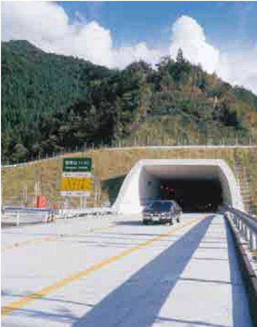
中央自動車道恵那山トンネル[中津川方](1975、岐阜県)
