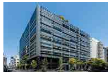
グリーン・リニューアル ZEB 化した 関西支店ビル
