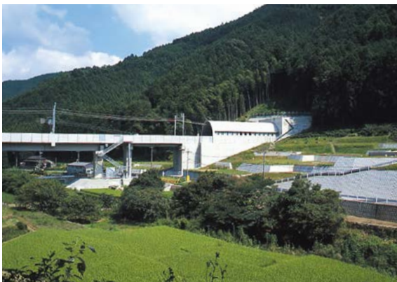
九州新幹線田上トンネル
