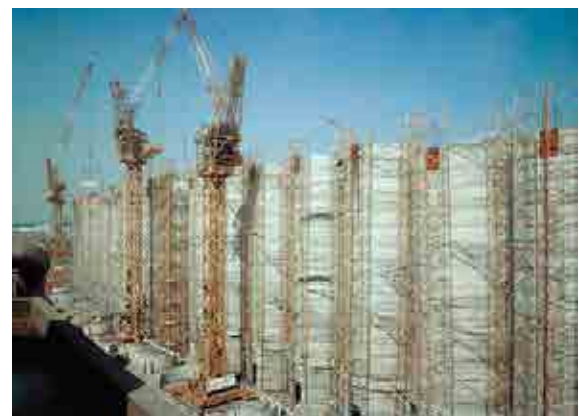
工事中的日清製油横浜磯子工場のサイロ
