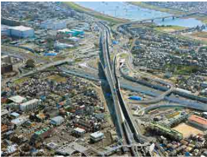
東京外かく環状道路 田尻工事(2019、千葉県)
