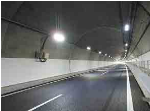
新名神高速道路 箕面トンネル東(下り線)
