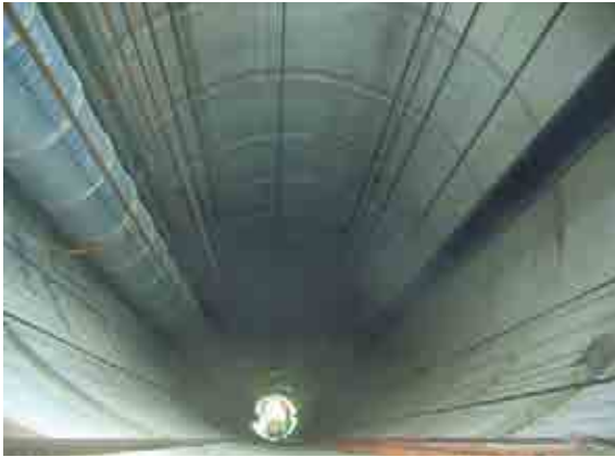
幌延地下施設(東立坑)
