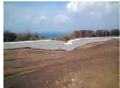
完成した三宅島導流堤
