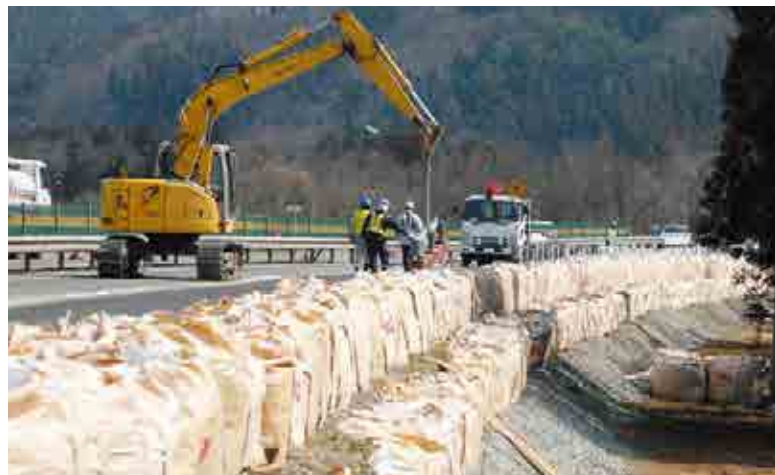
震災時、山形自動車道での緊急補修作業
