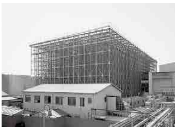
建設中の日石樹脂化学(現・JX日鉱日石エネルギー)川崎工場
