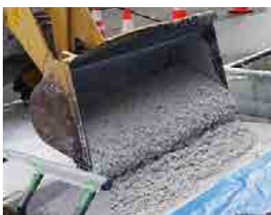
現場打ち舗装施工状況
