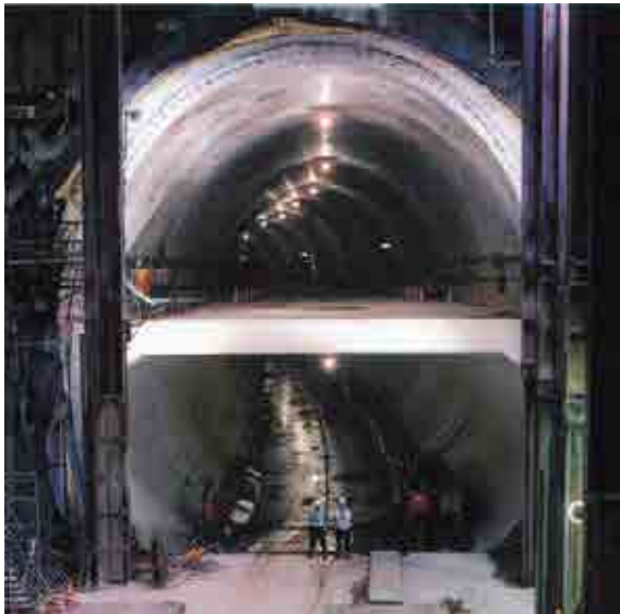
上下線を1階と2階に振り分けた青梅トンネル
