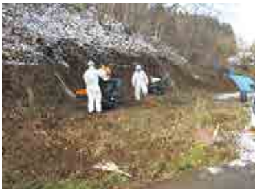
飯舘村除染等工事
