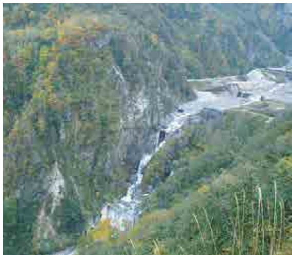
砂防施設では初の重文指定となった白岩砂防堰堤
