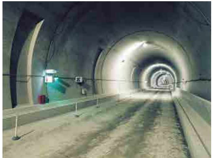
阪神高速31号神戸山手線高取山トンネル[北行] (2002、兵庫県)
