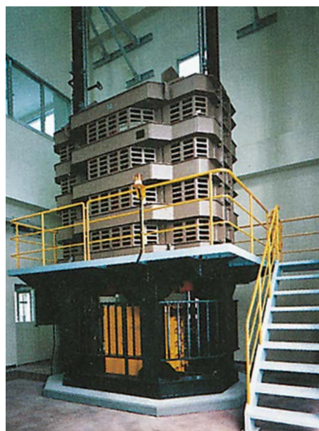
リニアモーターを適用したドロップタワーの制動部
