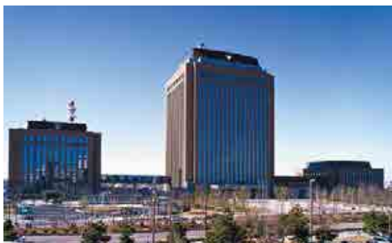
長寿命建築として設計された石川県庁舎
