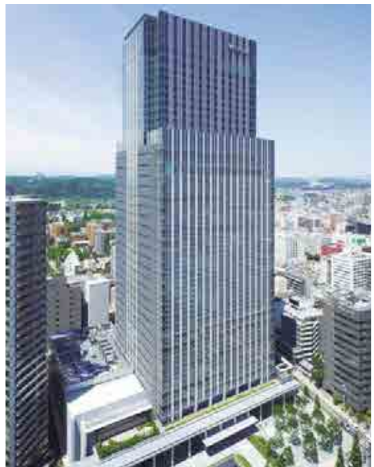
仙台トラストタワー (2010)
