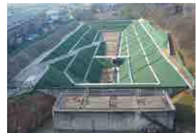
八千代市で施工中の最終処分場恒久対策工事
