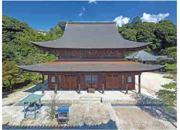
国宝不動院金堂及び重要文化財不動院鐘楼[保存修理](2014、広島県)
