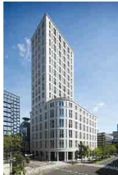
花崗岩打ち込みの PCa 板を 外壁に使用した本町ガーデンシティ
