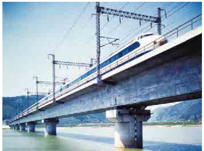
山陽新幹線吉井川橋梁(1970、岡山県)
