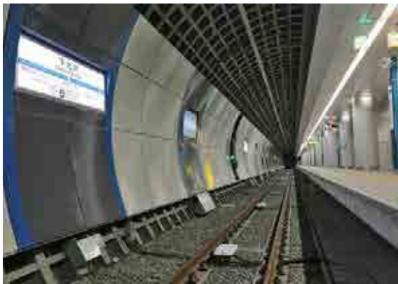
代々木上原駅・梅ヶ丘駅間線増連続立体交差工事 [土木・第3工区] 小田急電鉄下北沢駅急行線階上り線および乗降場
