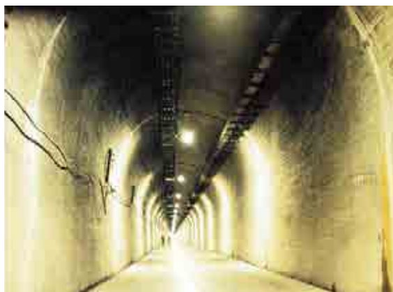
沼原発電所の地下空洞
