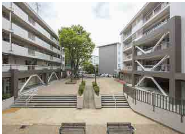
分譲マンションの耐震改修工事例
