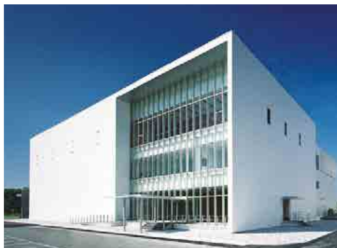
塩野義製薬 摂津工場208棟(2008、大阪府)
