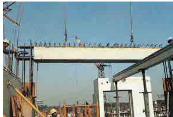
② PCa 梁建方
