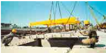
PCa床取り付け工事
