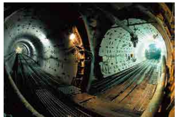
観音川雨水滞水池導水渠
