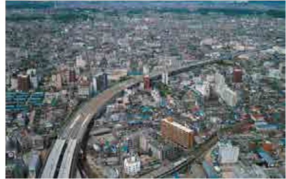
在来線と接した東北新幹線仙台小田原地区高架橋
