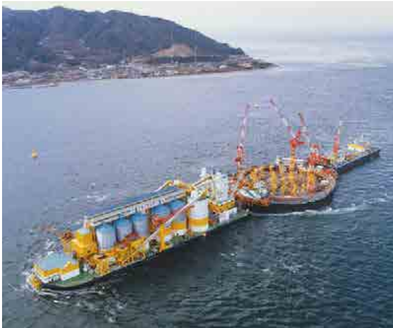
明石海峡大橋 3P 下部工工事における 特殊水中コンクリート打設
