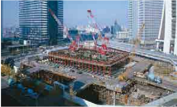
工事初期の新宿センタービル
