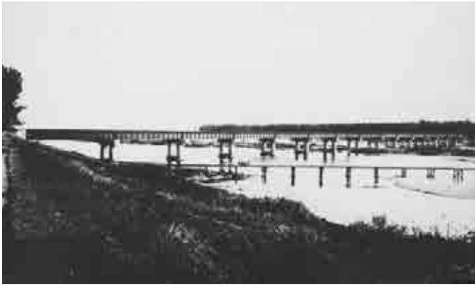
参宮急行電鉄宮川橋梁(1929、三重県)
