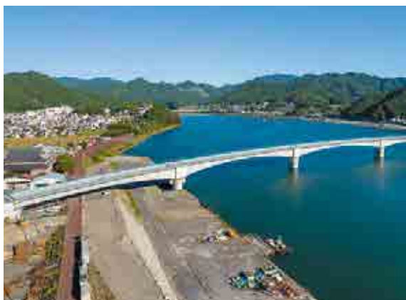
新宮紀宝道路熊野川河口大橋 P1-P3 上部工事
