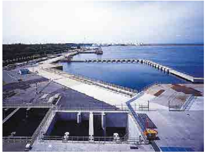
東北電力 東新潟火力発電所4号系列(2000)
