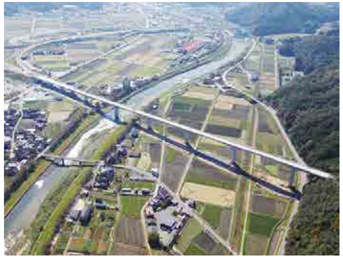
和田山八鹿道路 円山川橋(2011、兵庫県)
