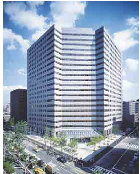
アーバンネット大手町ビル(1990)
