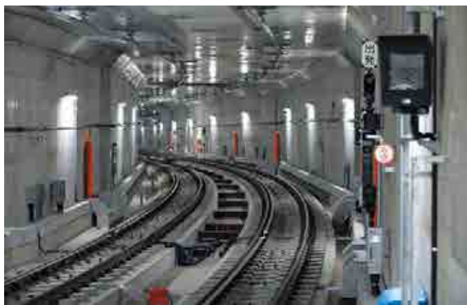
(13号相直) 渋谷駅建設二期工事[土木工事] (2015)
