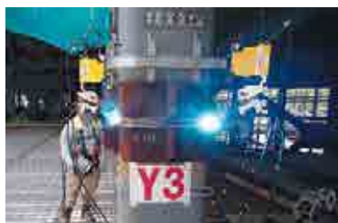
T-iROBO Welding の現場でのロボット溶接状況
