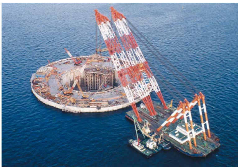
工事中の東京湾横断道路の川崎人工島
