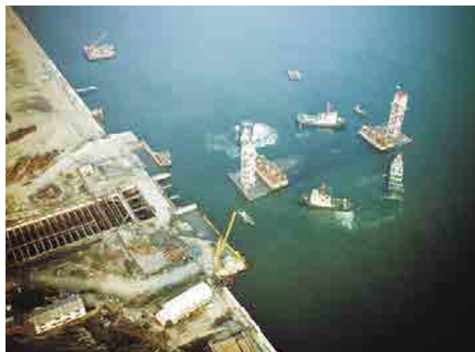
日本鋼管扇島連絡海底トンネル(1974、神奈川県)
