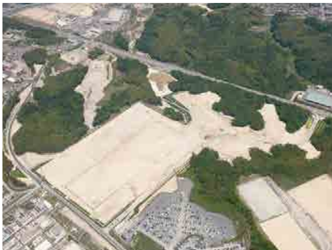
東芝四日市新工場[敷地造成] (2011、三重県)
