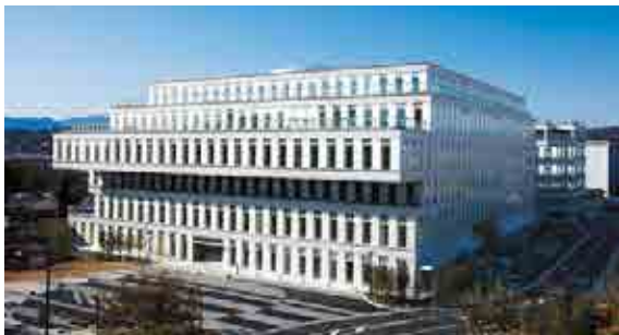
高崎市総合保健センター・高崎市中央図書館
