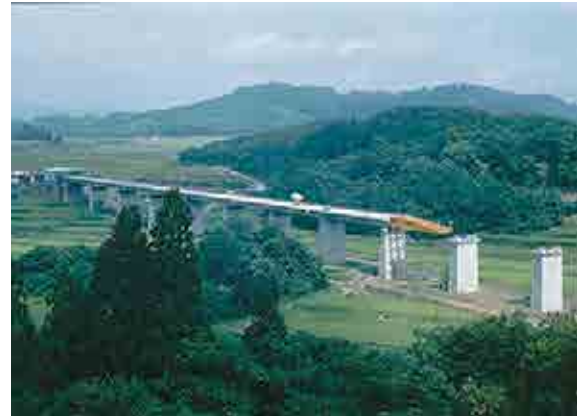
建設中の東北新幹線猿ヶ石橋梁
