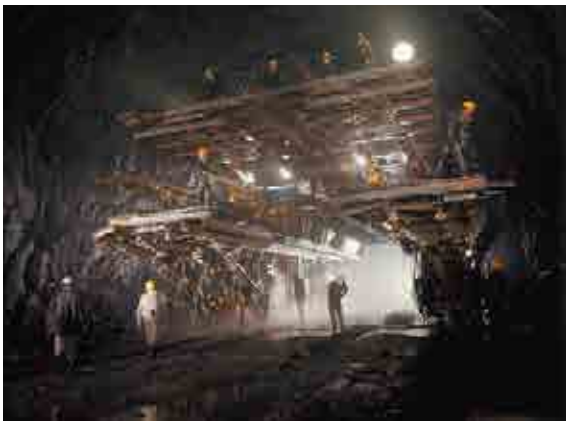
大清水トンネル掘削現場
