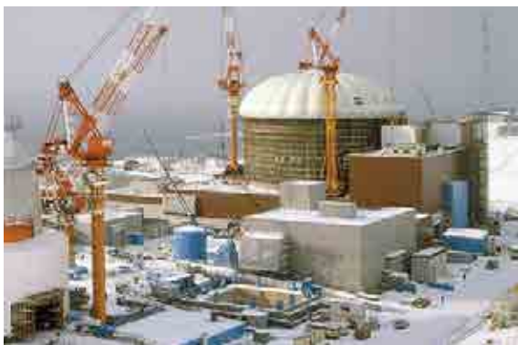
空気膜で覆われた建設中の北海道電力泊発電所
