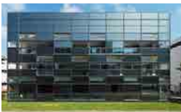
ZEB 実証棟 (完成当時)
