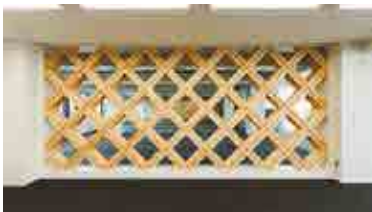
T-WOOD BRACE 適用例
