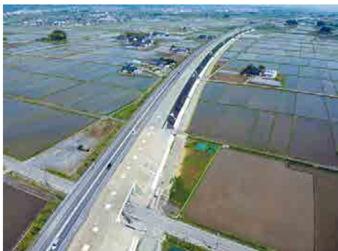
常磐自動車道 岩沼工事(2020、宮城県)
