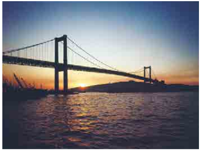
九州自動車道若戸大橋[下部工、若松側](1961、福岡県)
