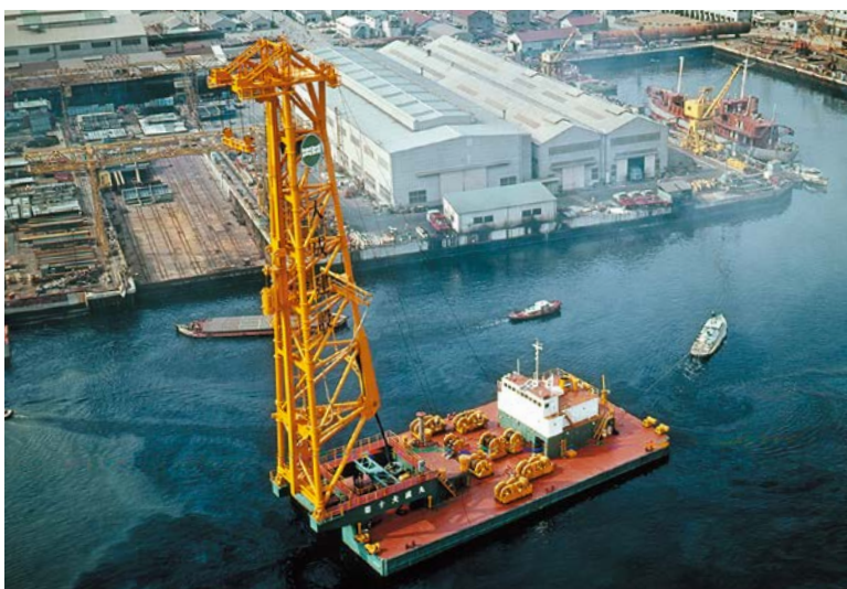
大型杭打船、第10大成丸
