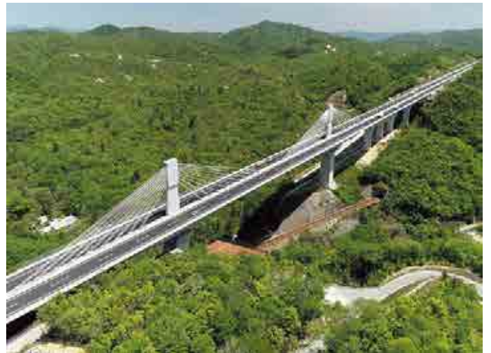
新名神高速道路 生野大橋(2019、兵庫県)
