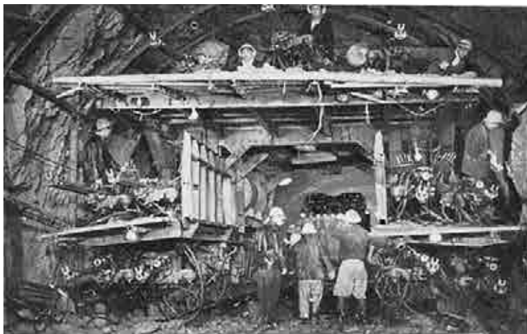
電源開発奥只見発電所道路隧道、 全断面掘削機
