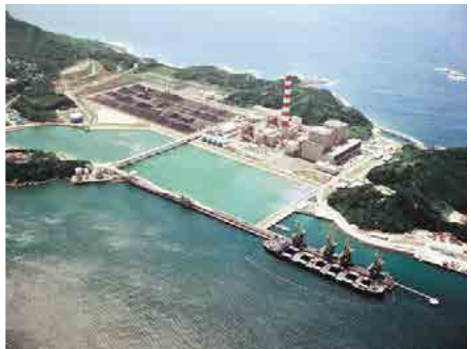
電源開発松島火力発電所棧橋(1980、長崎県)
