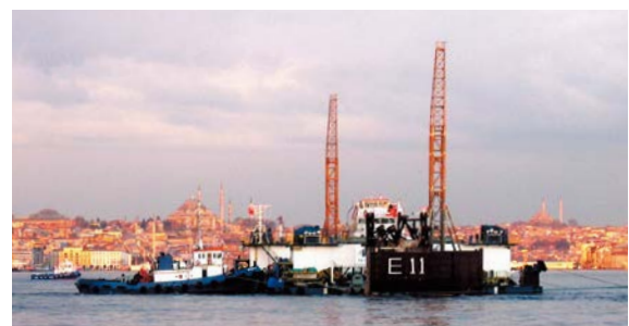
ボスポラス海峡横断鉄道トンネルで沈設場所に曳航された沈埋函
