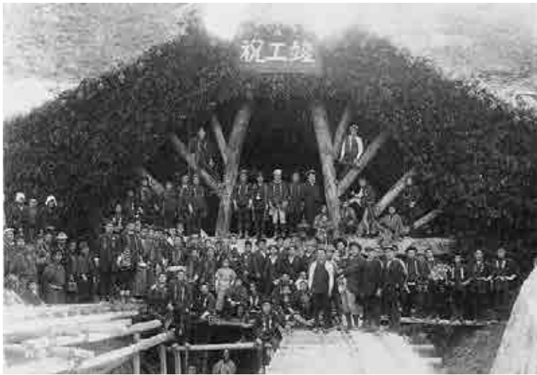
神戸市湊川改修 会下山隧道東口竣工記念写真
