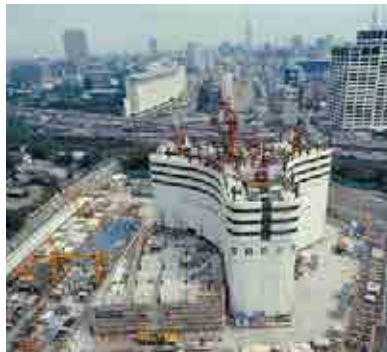
タワー中層部の工事
