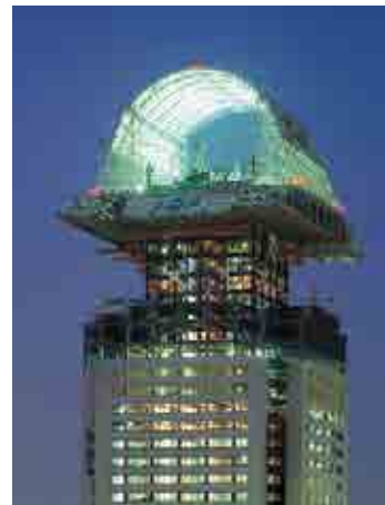
T-UP 工法で施工中の三菱重工横浜ビル
