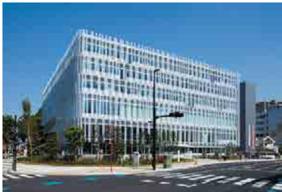
大宮区役所新庁舎
