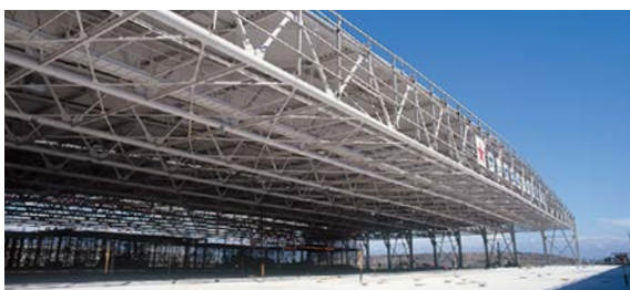
SDC 構法を適用した施工中のサッポロビール千葉工場
