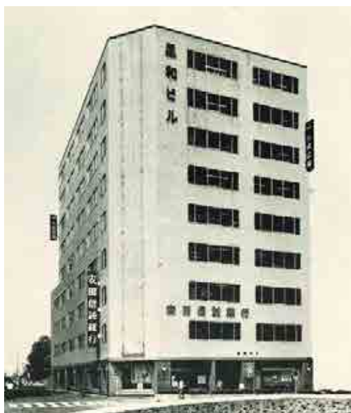
星和ビル （東京都新宿区） 1965～1986年
