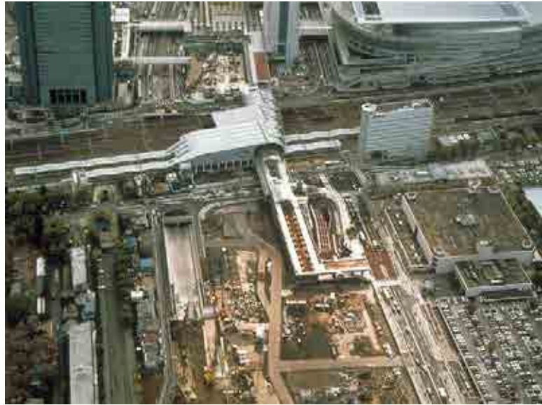
施工中のさいたま新都心駅
