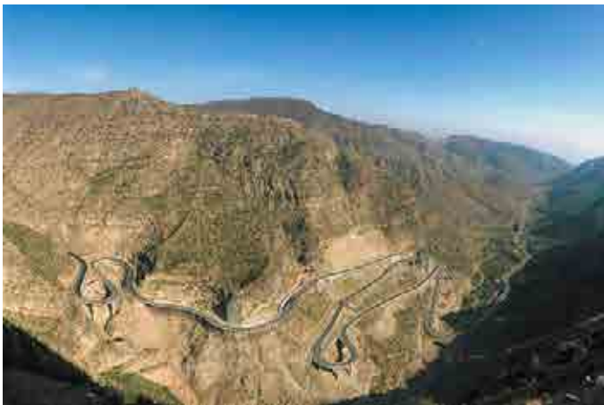
パキスタン・東西道路改修事業(国道70号線)(2019)
