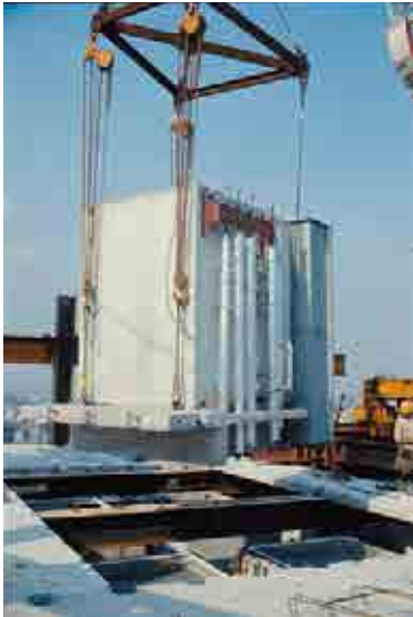
ホテルニューオータニタワーの現場敷地内 工場で製造したユニットバスの据え付け
