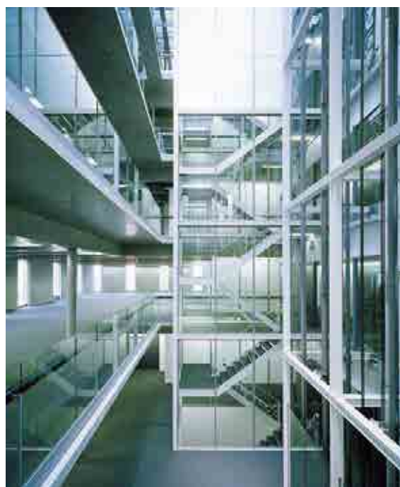
TASMO を採用し間仕切りや壁のほとんどない開放的な空間を生み出した大成札幌ビル(内観)
