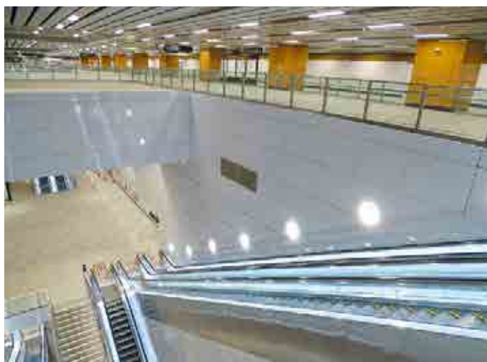
シンガポール・トムソン東海岸線建設工事T226工区(2022)
