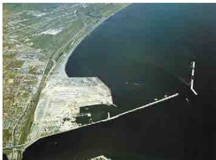
釧路西港岸壁(1981、北海道)
