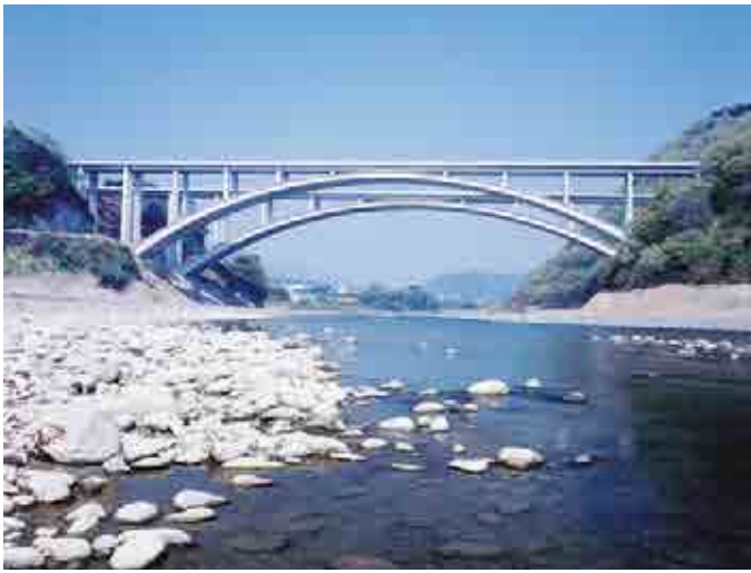
第二東名高速道路 富士川橋(2005、静岡県)
