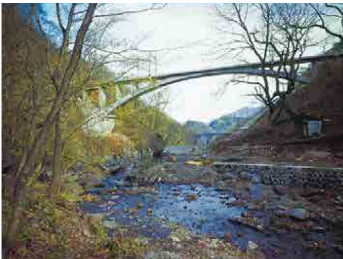
信越本線新碓氷川橋梁(1963、群馬県)
