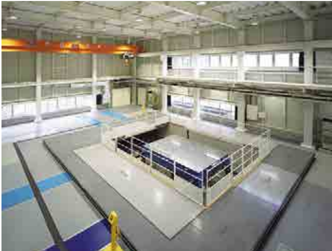
NTT 武蔵野研究開発センタ新振動実験棟[増築](2010)
