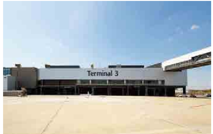
成田国際空港 第3旅客ターミナルビル(2015、千葉県)
