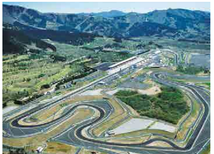
富士スピードウェイ[改修造成](2005、静岡県)
