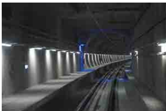
開通したボスポラス海峡横断鉄道トンネル内部
