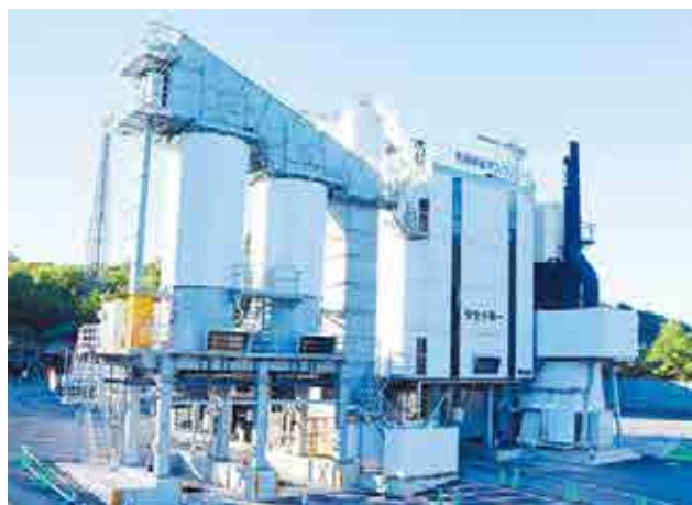
札幌合材工場（札幌中央アスコン）
