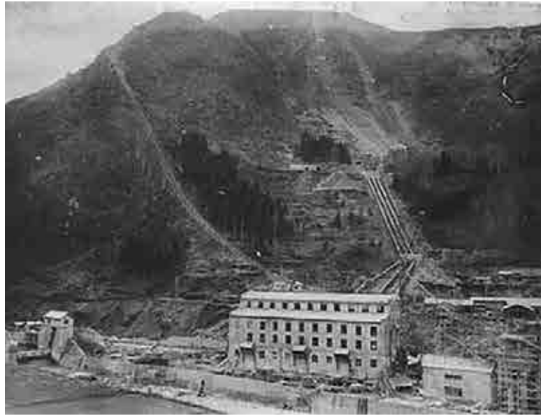
信濃川支流中津川水力発電所工事
