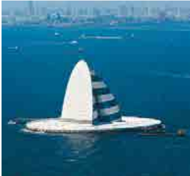
風の塔と名付けられた 東京湾横断道路川崎人工島の換気施設 (写真提供：NEXCO 東日本)
