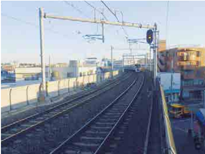
京成本線(船橋付近) 連続立体交差[第5工区] (2008、千葉県)
