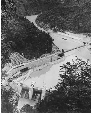
大井川発電所水路
