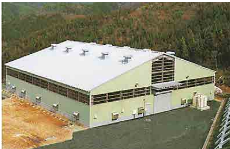
埋立地を屋根で覆った中泊町一般廃棄物 最終処分場
