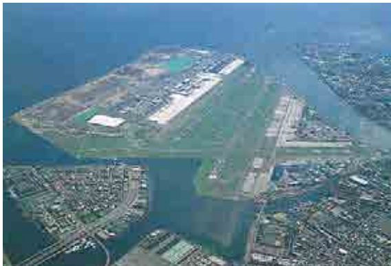
沖合展開が進む東京国際空港
