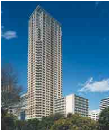
南青山一丁目団地建替プロジェクトで完成したパークアクセス青山一丁目タワー
