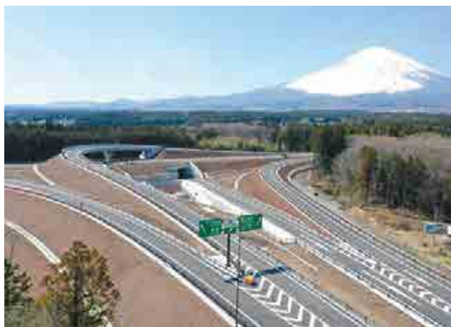
令和元年度 138 号 BP 仁杉地区舗装工事
