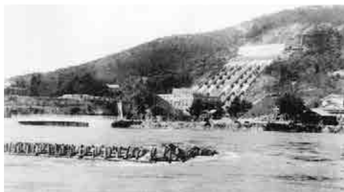
宇治川電気宇治川発電所(1913、京都府)
