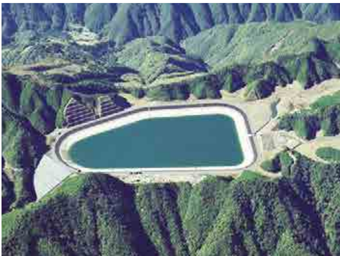
九州電力小丸川発電所[第1工区1期](2007、宮崎県)
