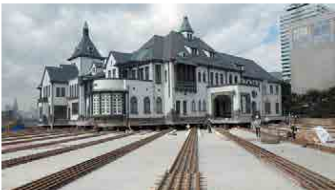
旧グランドプリンスホテル赤坂 旧館(旧李王家東京邸) [曳家工事] (2015)
