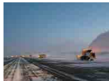
新千歳空港 (除雪風景) (画像提供：北海道エアポート)
