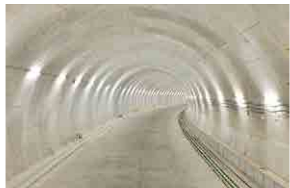
完成した首都高速中央環状品川線トンネル
