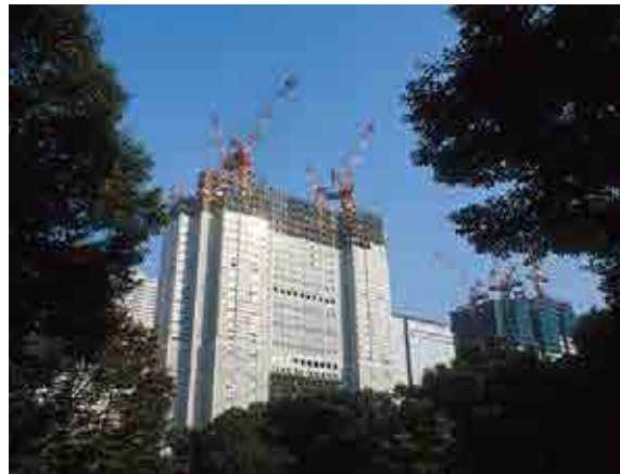
建設中の東京都第一本庁舎
