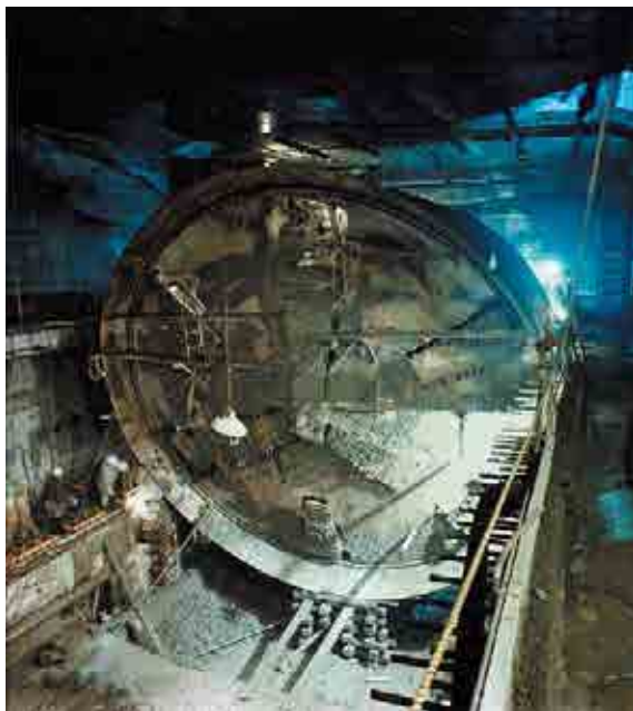
近鉄難波シールド工事現場の傾斜カッターヘッド型機械シールド
