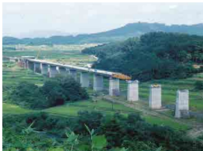
東北新幹線猿ヶ石橋梁[上部工](1977、岩手県)
