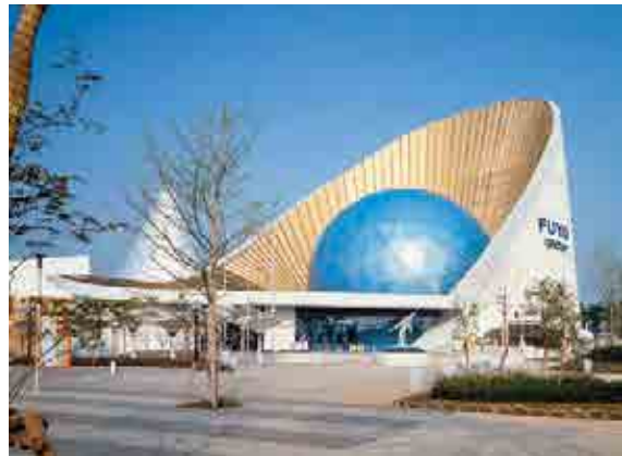
ロボットショーが話題となった芙蓉ロボット・シアター
