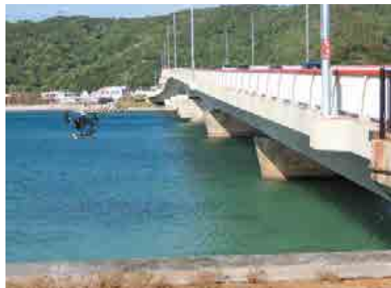
ドローンによる橋梁の撮影状況
