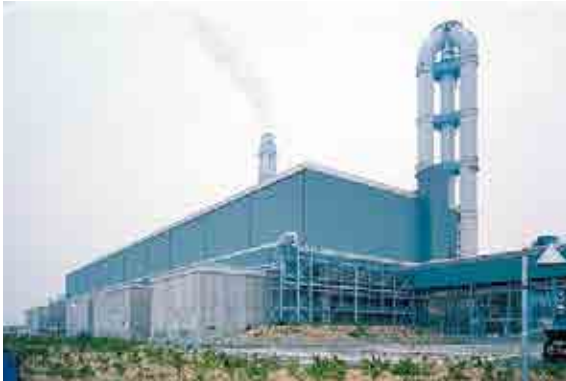
横引き工法で建設された中部電力川越火力発電所
