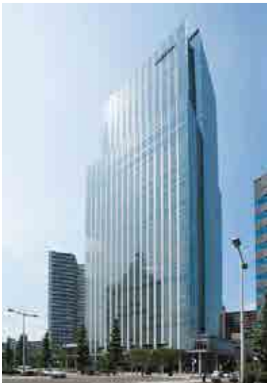
東日本大震災において制振機能が確認された仙台トラストタワー
