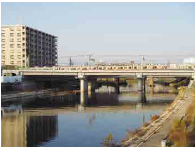
山陽電鉄明石市内連続立体交差(2013、兵庫県)
