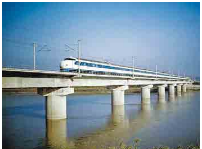
東海道新幹線矢作川橋[上部工](1963、愛知県)
