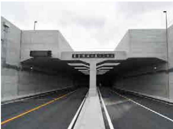
東京港 海の森トンネル
