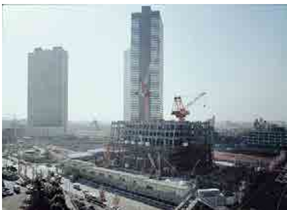
建設中の安田火災海上本社ビル
