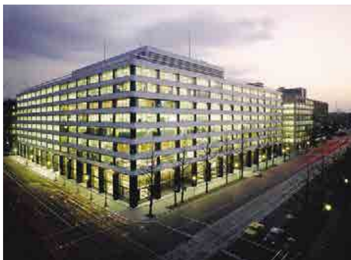
新東京ビルヂング(1963)
