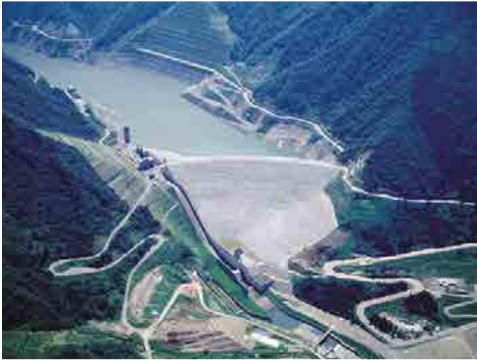
三国川ダム(1993、新潟県)
