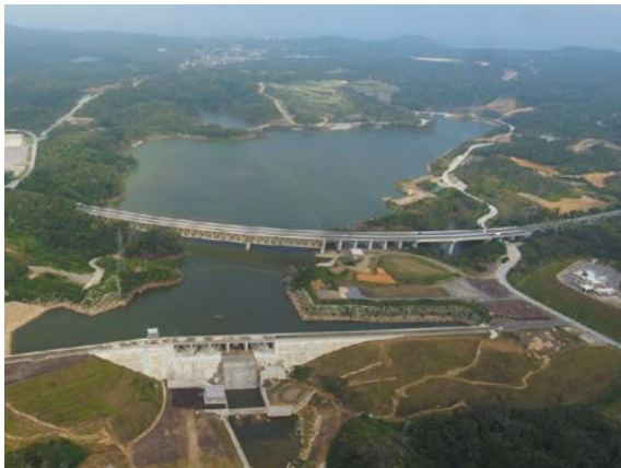
完成した億首ダム
