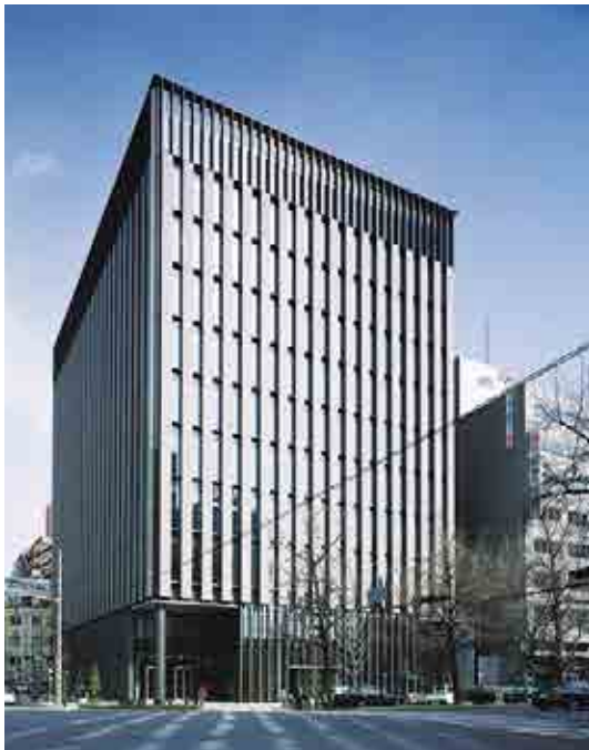
あいおい損保御堂筋ビル(2005、大阪府)
