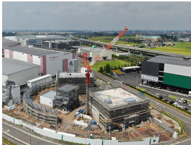
写真1 現在建設中のゼロカーボンビル
