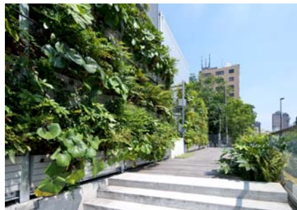
早稲田大学 65 号館壁面緑化
