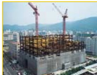
勇軒台北廠新築工事 (台湾)
