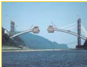
第二東名高速道路富士川橋工事 (静岡県庵原郡)
