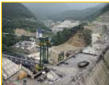
福智山ダム建設工事 (福岡県直方市)
