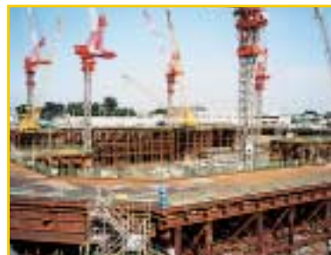
東京都水道局朝霞浄水場 高度浄水施設築造工事 (埼玉県朝霞市)
