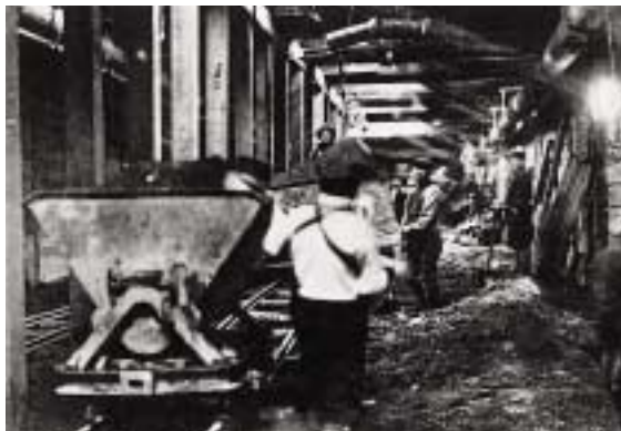
当時の建設工事の様子。掘り出した土砂はトロッコで運び出す。
