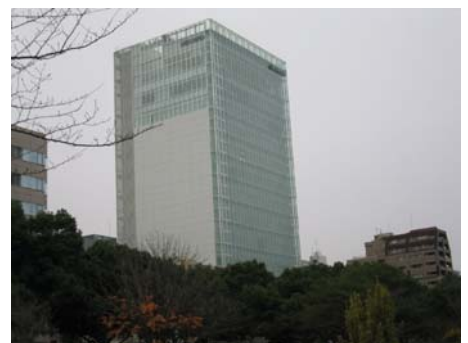
■ Mビル (名古屋市)
