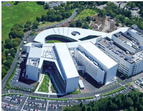
▲ 筑波新棟建設工事 (茨城県) 発注者:アステラス製薬(株)
