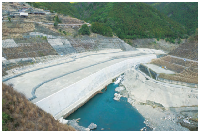
▲ 白屋地区地すべり対策工事 (奈良県) 発注者:近畿地方整備局
