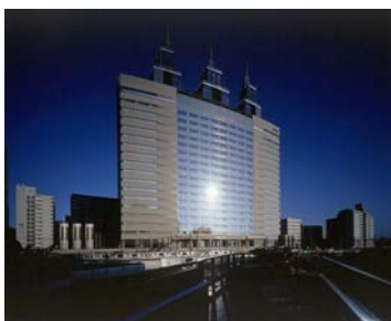
NTT Docomo川崎ビル
