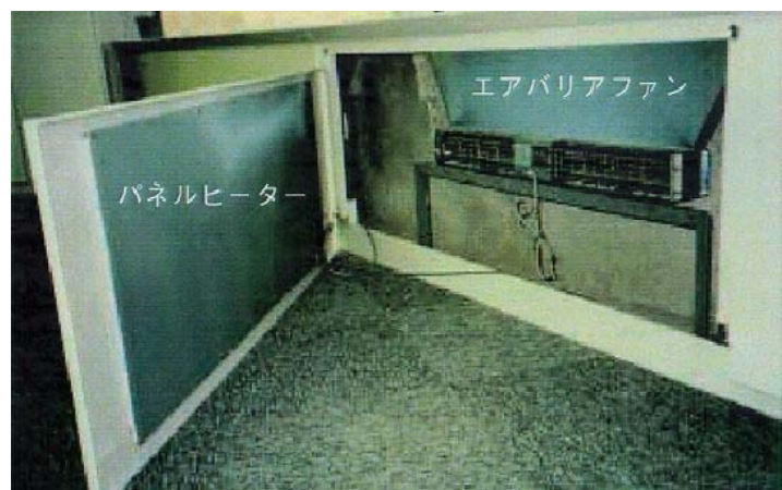
施工例（窓台内部）
