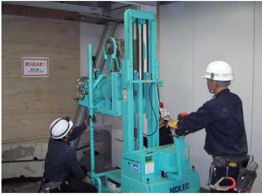
ブレース(斜材)取付状況
