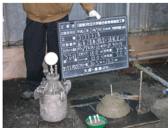
写真-2 コンクリート品質試験 Quality Test of Concrete
