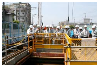
掘削現場を見学
