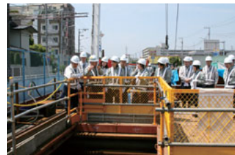
国道1号原宿交差点立体工事作業所見学
