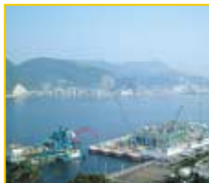
長崎港(女神地区)橋梁(3P)基礎 (ニューマチックケーソン工)工事 (長崎県長崎市)
