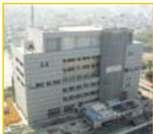
在インドネシア 日本国大使館新築工事 (インドネシア共和国)
