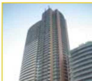
河田町市街地住宅C棟建設工事 (東京都新宿区)
