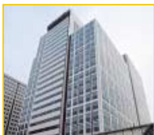
品川シーサイドフォレスト 業務B棟新築工事 (東京都品川区)
