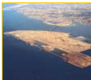
空港島造成工事(その3)/中部国際空港 旅客ターミナルビル新築工事(その1) (愛知県常滑市)
