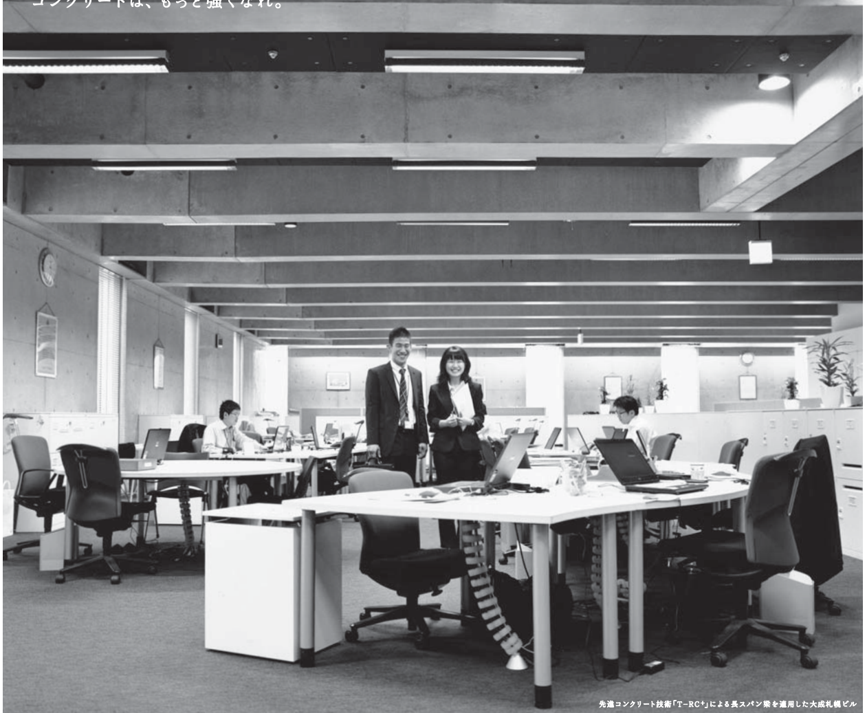
先進コンクリート技術「T-RC+」による長スパン梁を適用した大成札幌ビル
