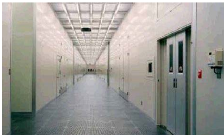
■アウトガス対策をしたウルトラクリーンルーム
