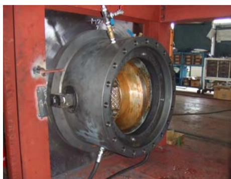
カッターホルダー回転完了 背面カバー取外完了
