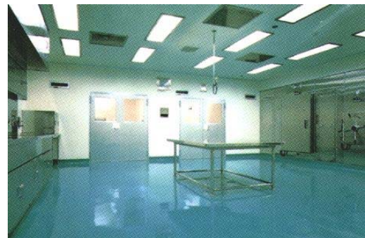
■バイオクリーンルーム
